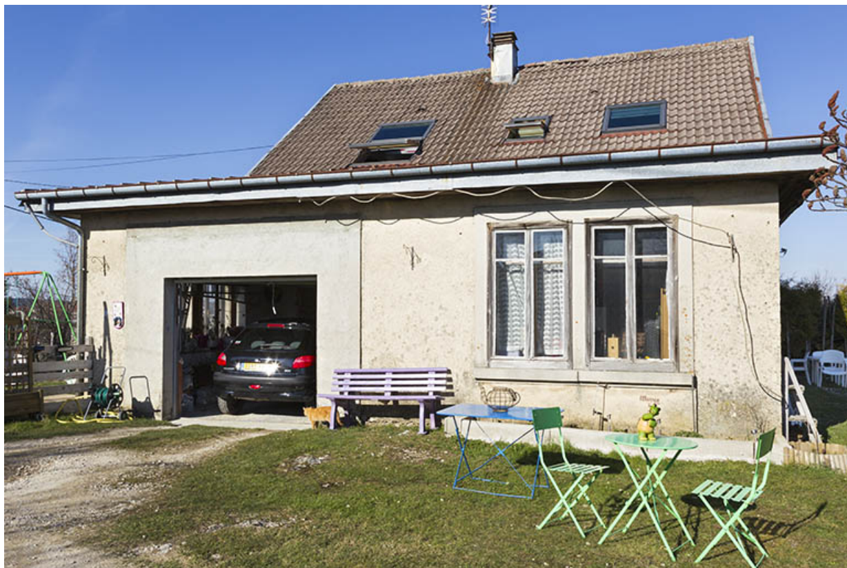
Atelier de fabrication : façade latérale gauche.
