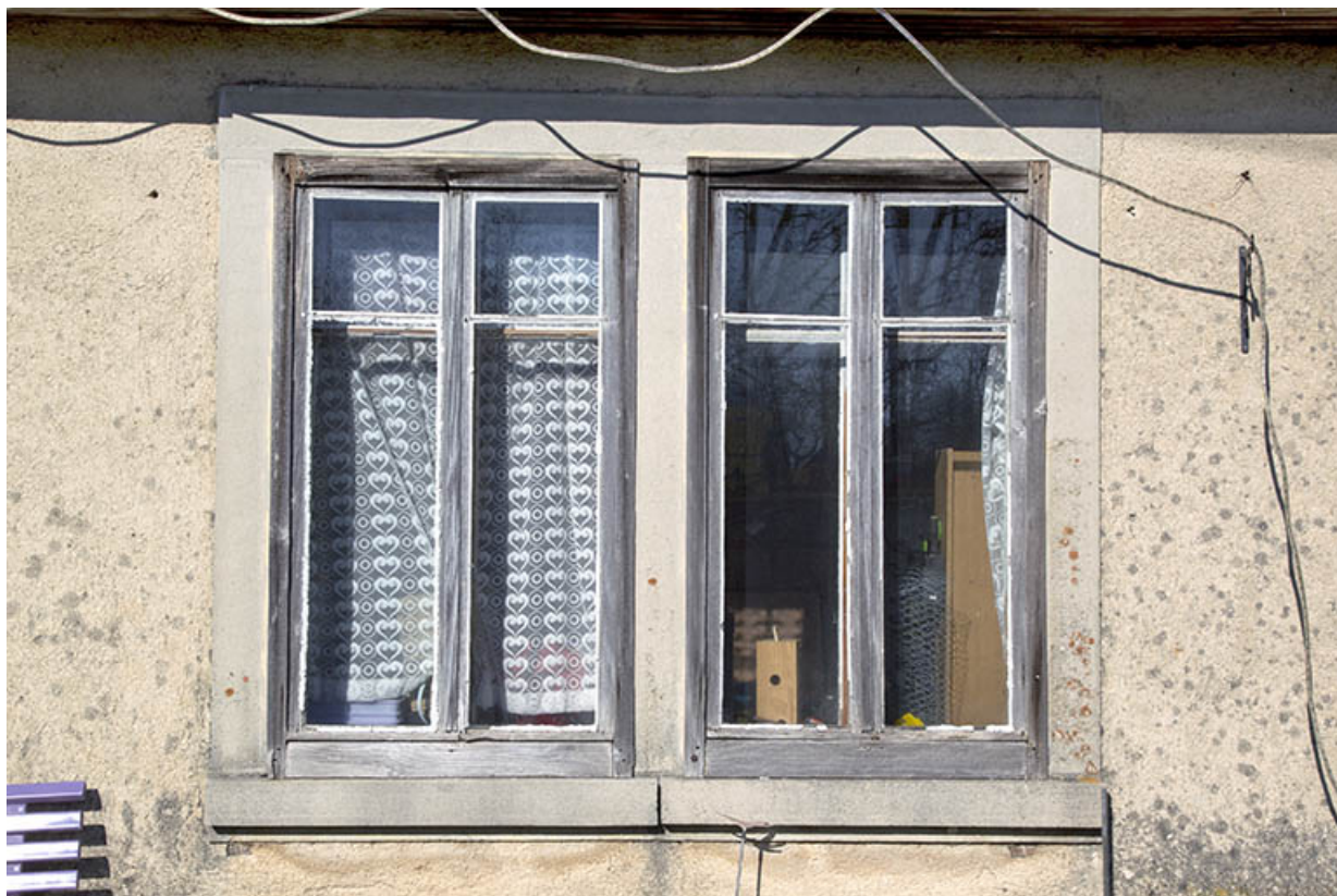
Atelier de fabrication : fenêtres horlogères sur la façade latérale gauche.
