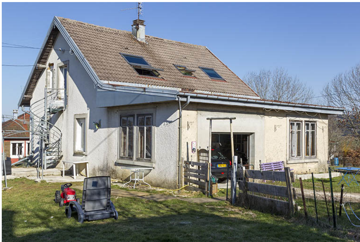
Vue d'ensemble, depuis l'ouest (façades postérieure et latérale gauche). 25, Charquemont, 7 bis rue de la Fontenotte
