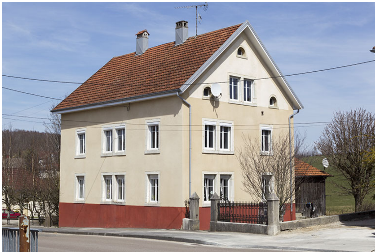
Vue d'ensemble, depuis le sud (façades antérieure et latérale gauche). 25, Charquemont, 3 Grande Rue
