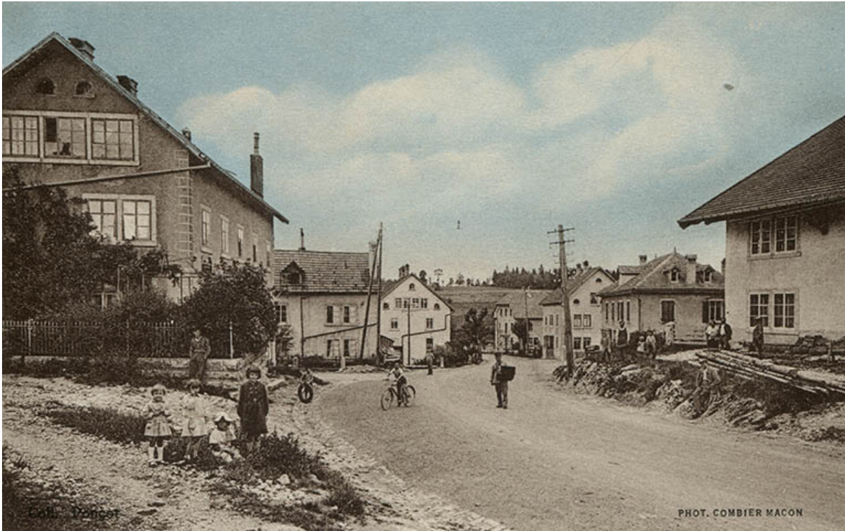
Charquemont (Doubs) - Rue de Maîche [près du carrefour de la Rue Neuve], 2e quart 20e siècle. 25, Charquemont, 3 Grande Rue
