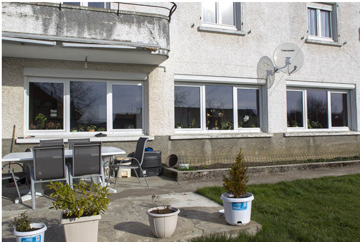
Façade postérieure : fenêtres de l'atelier. 25, Charquemont, 2 rue Mermoz
