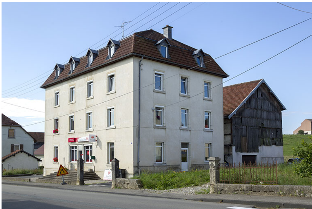
Vue d'ensemble, depuis le nord : logement patronal en avant du bâtiment d'écurie et fenil. 25, Charquemont, 50 et 52 Grande Rue
