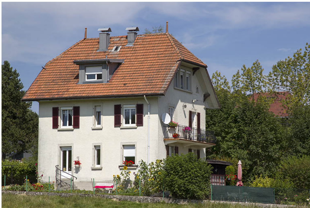
Une maison des années 1920 (vers 1926) et son atelier d'horlogerie : maison Chapuis (16 rue du Château). 25, Charquemont, 16 rue du Château
