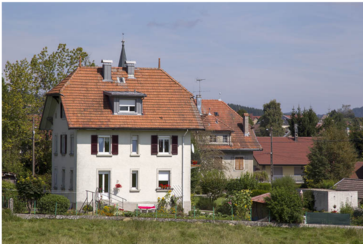
Vue d'ensemble, depuis l'ouest (façades postérieure et latérale droite). 25, Charquemont, 16 rue du Château
