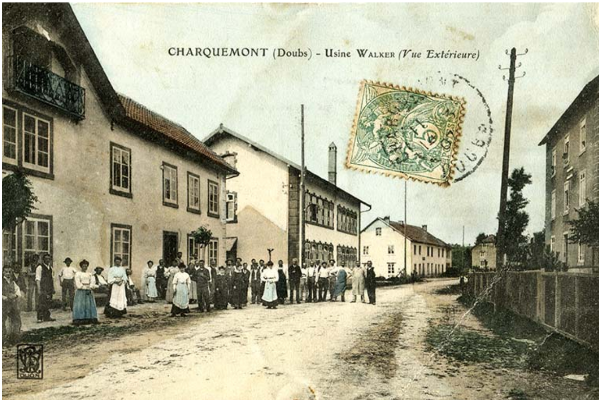
Charquemont (Doubs) - Usine Walker (vue extérieure), entre 1904 et 1907. La future usine Wasner occupe le premier plan à gauche. 25, Charquemont, 11 rue de l' Eglise
