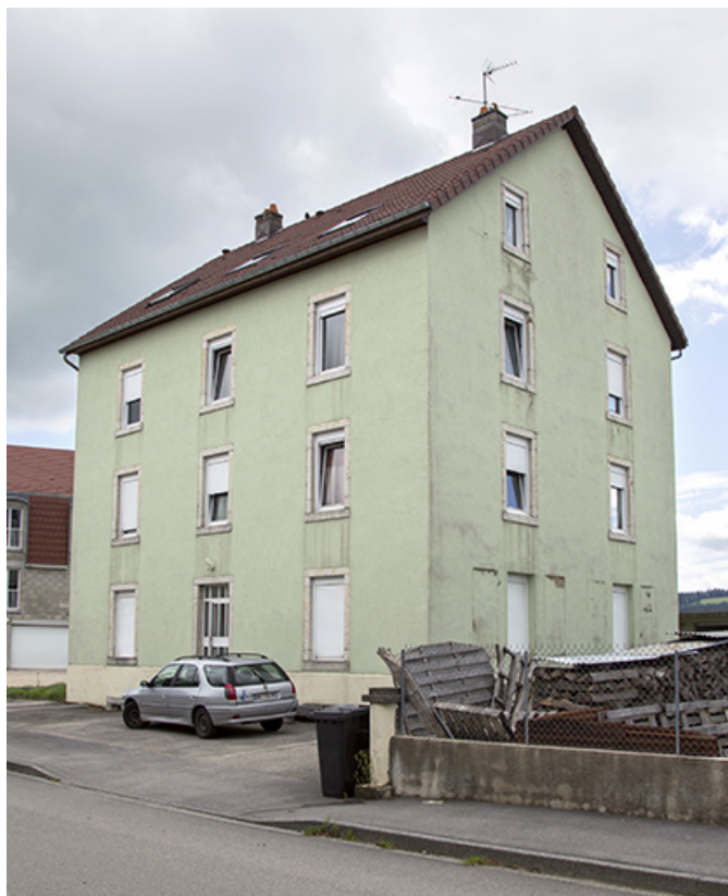
Façades antérieure et latérale droite.
