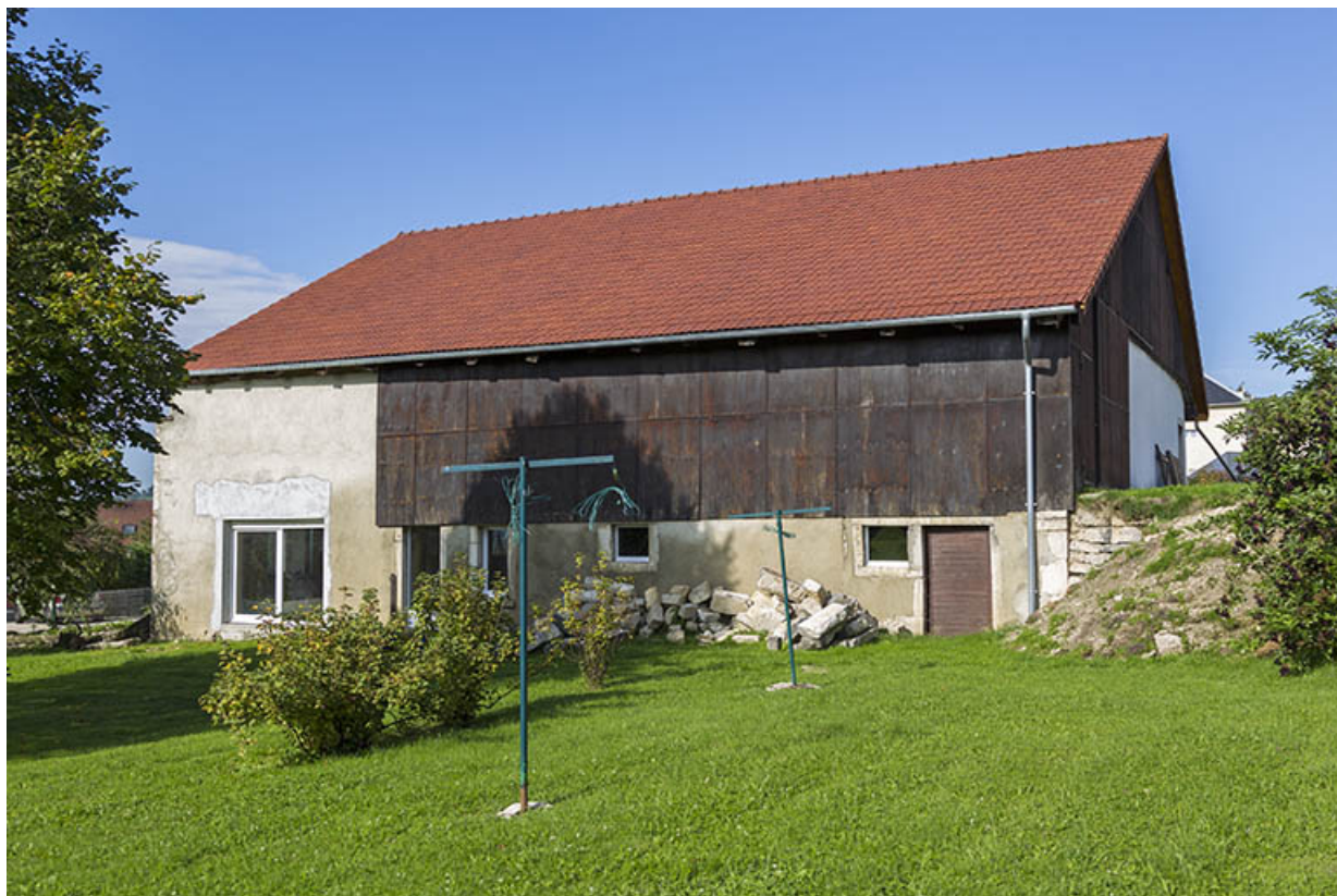
Façade latérale droite, de trois quarts droite.
