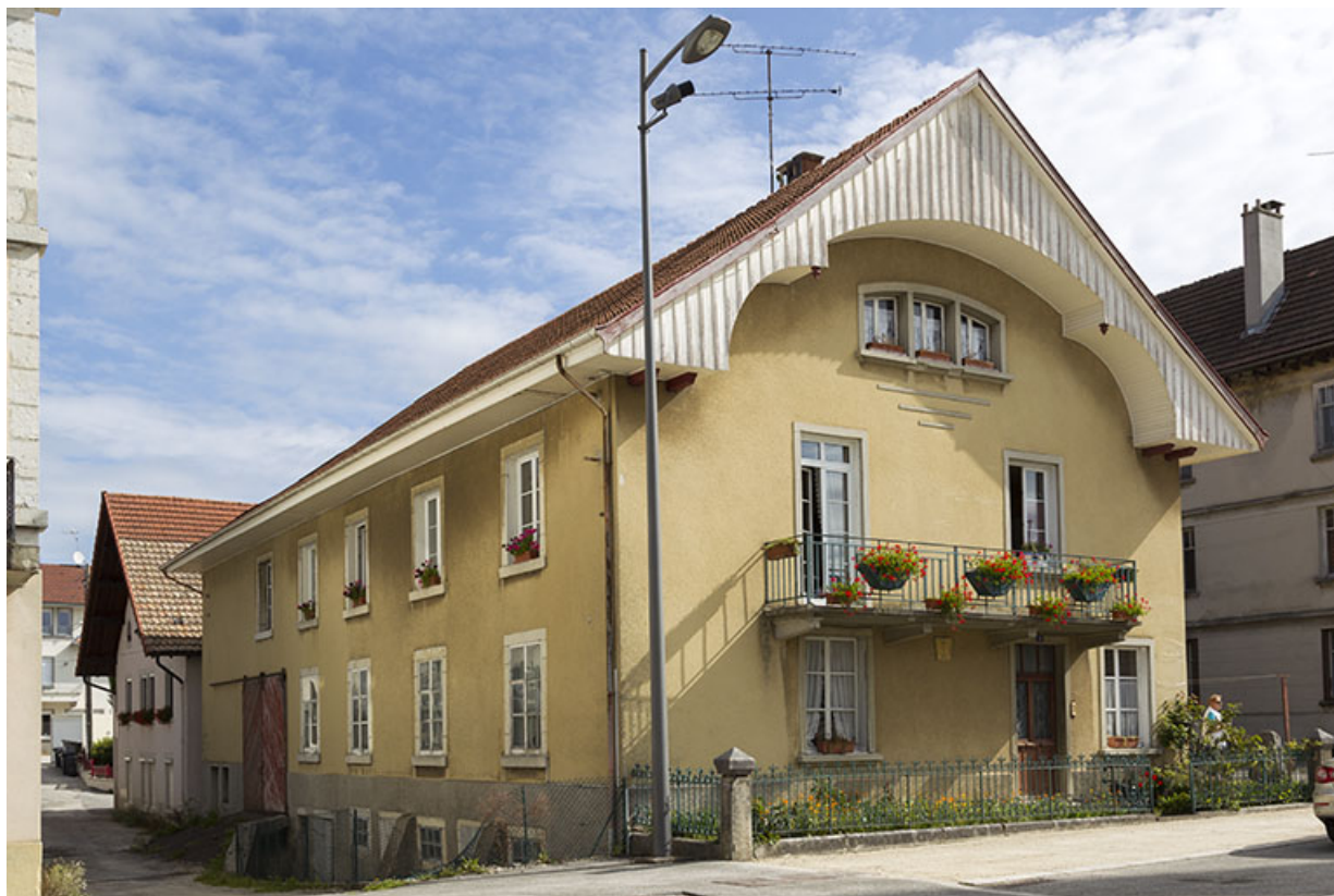
Corps de bâtiment principal : façades antérieure et latérale gauche.
