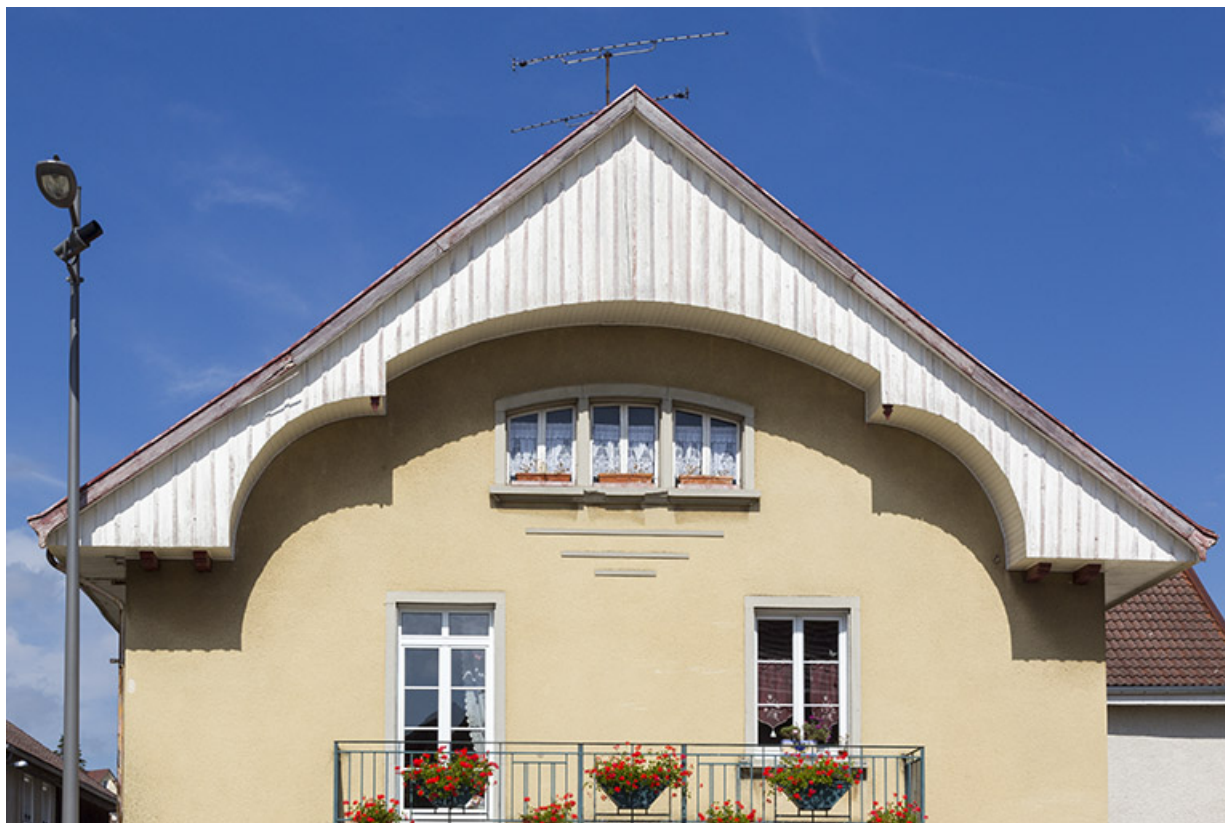
Corps de bâtiment principal, façade antérieure : niveaux supérieurs et lambrichure.
