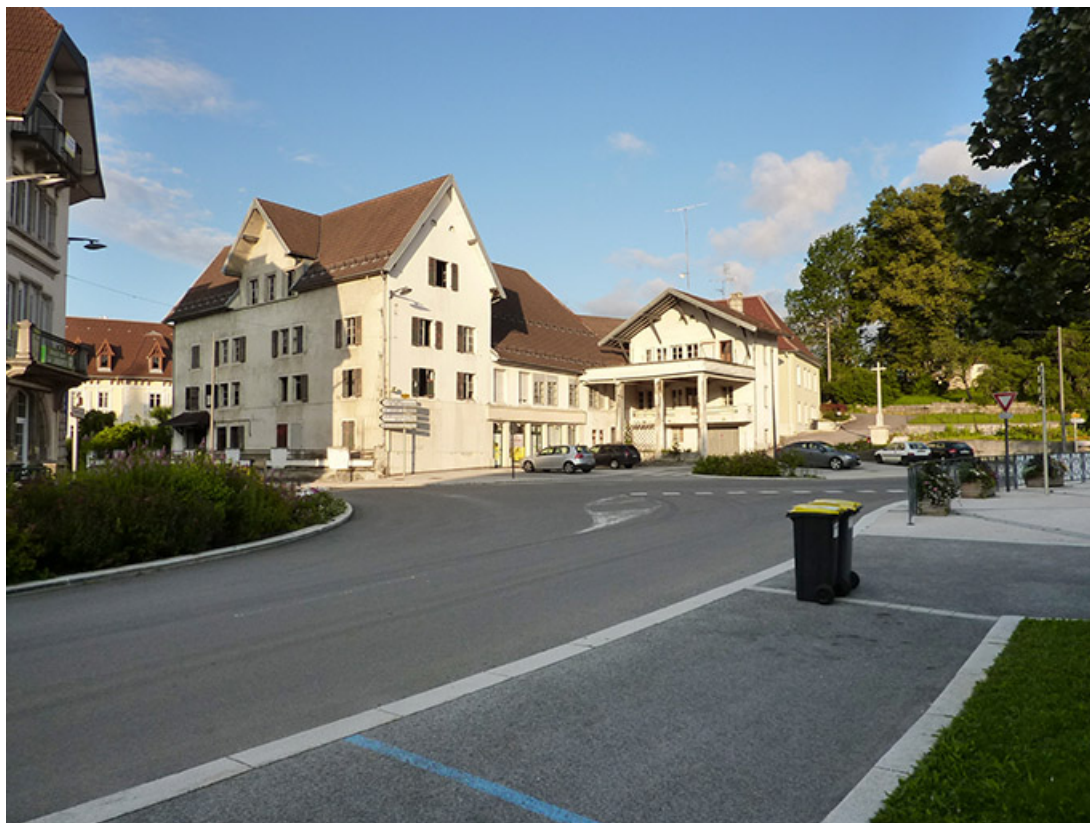
Vue d'ensemble depuis le nord-est, 17 juillet 2012.
