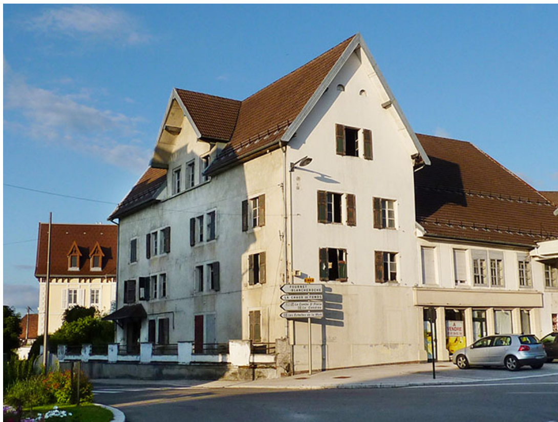
L'hôtel depuis le nord-est, 17 juillet 2012. 25, Charquemont place de l' Hôtel de Ville
