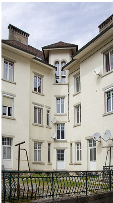
Façade postérieure : revers du pan coupé. 25, Charquemont, 19 Grande Rue
