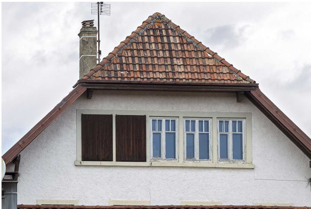
Façade postérieure : fenêtres multiples éclairant l'étage en surcroît.
