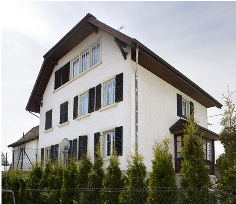
Vue d'ensemble, depuis l'est (façades postérieure et latérale gauche). 25, Charquemont, 7 rue du Château
