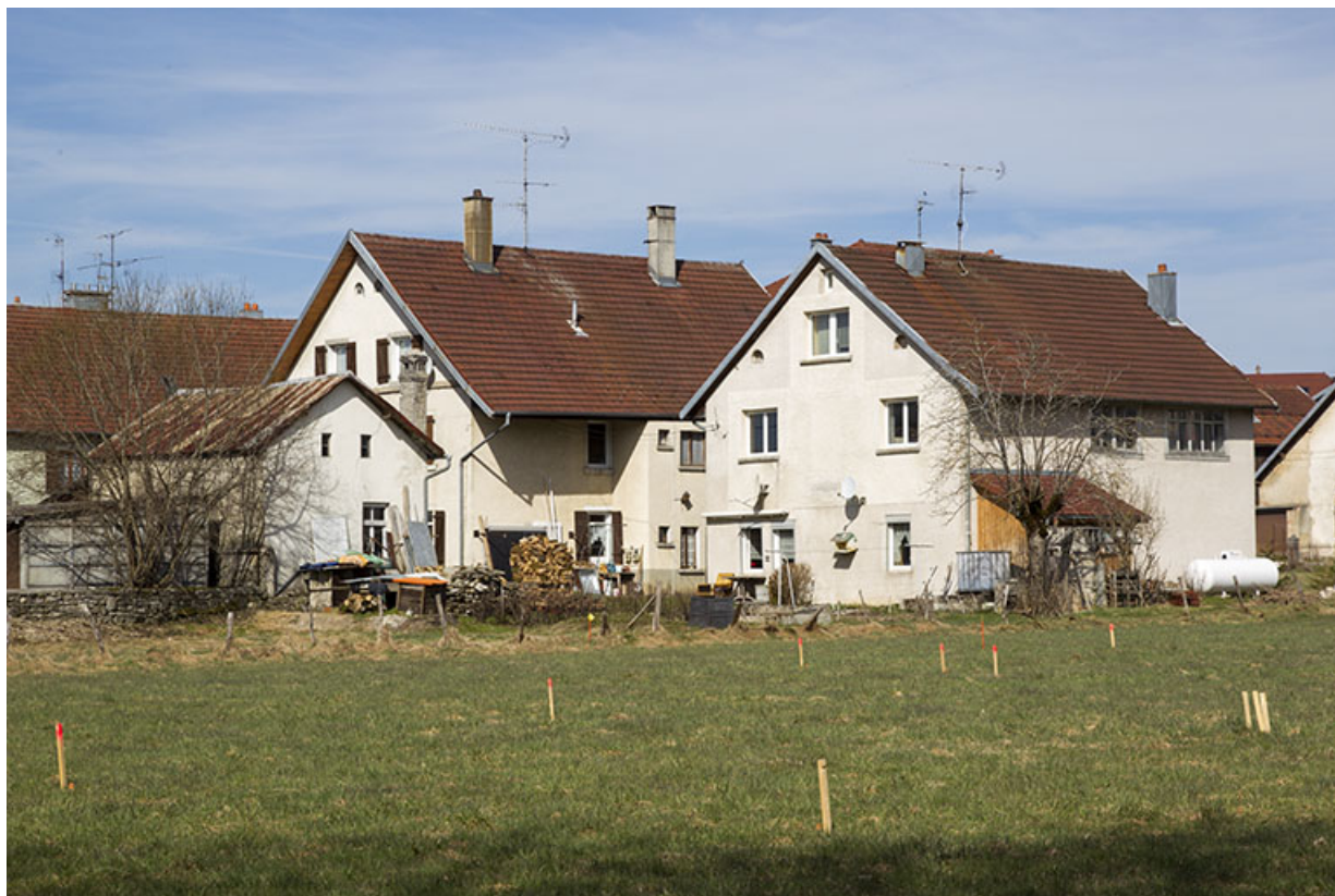
Vue d'ensemble, depuis le sud-ouest. Maison au n° 45 à gauche, au n° 47 à droite. 25, Charquemont, 45 et 47 Grande Rue
