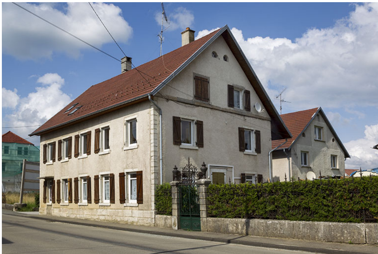
Maison au n° 45 : façades antérieure et latérale droite.
