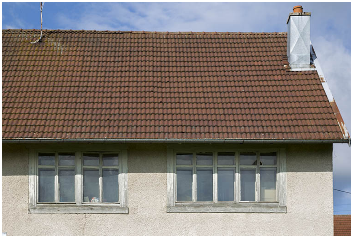
Maison au n° 47 : fenêtres horlogères sur la façade postérieure.
