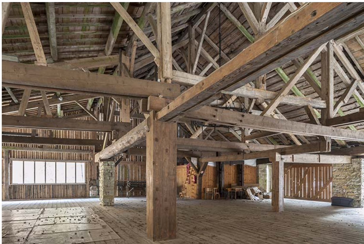
Vue intérieure de l'atelier de la scierie (après réhabilitation).
