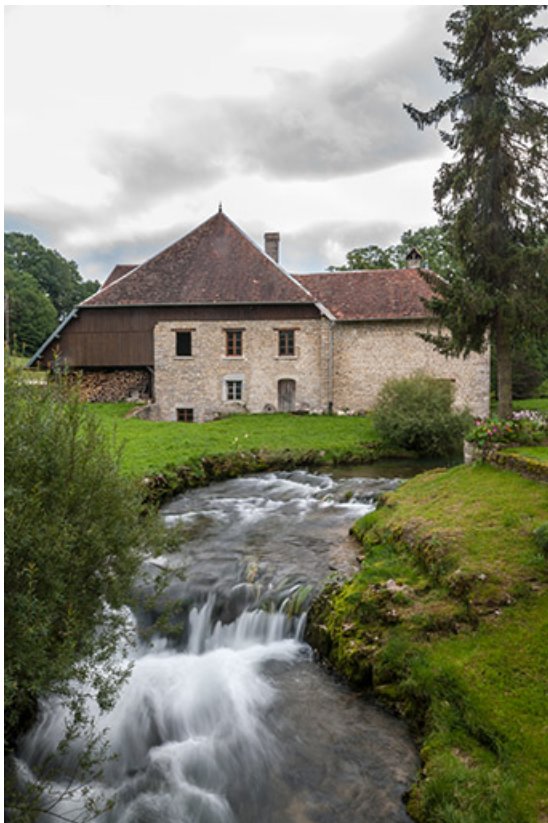
Vue d'ensemble depuis le nord-ouest (cadrage vertical). 25, Bremondans, lieudit : Amans
