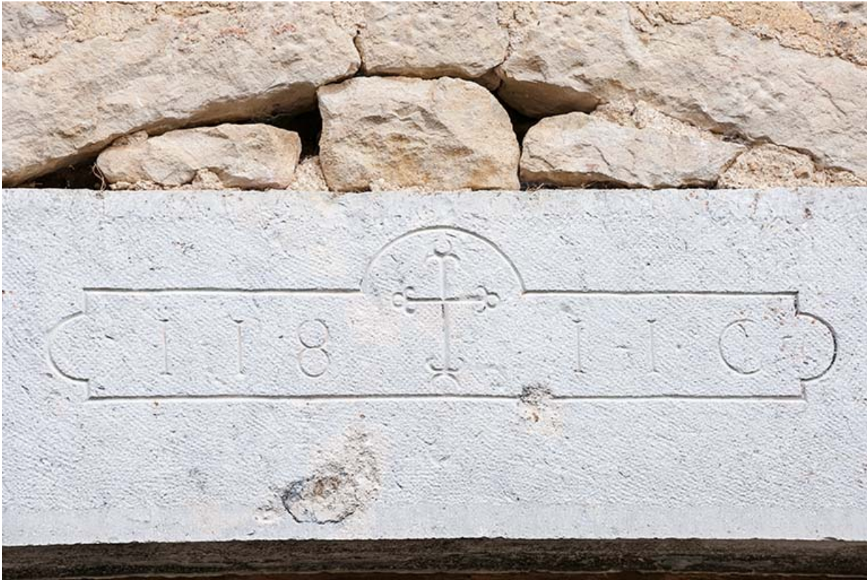
Détail d'un linteau de la façade sud.
