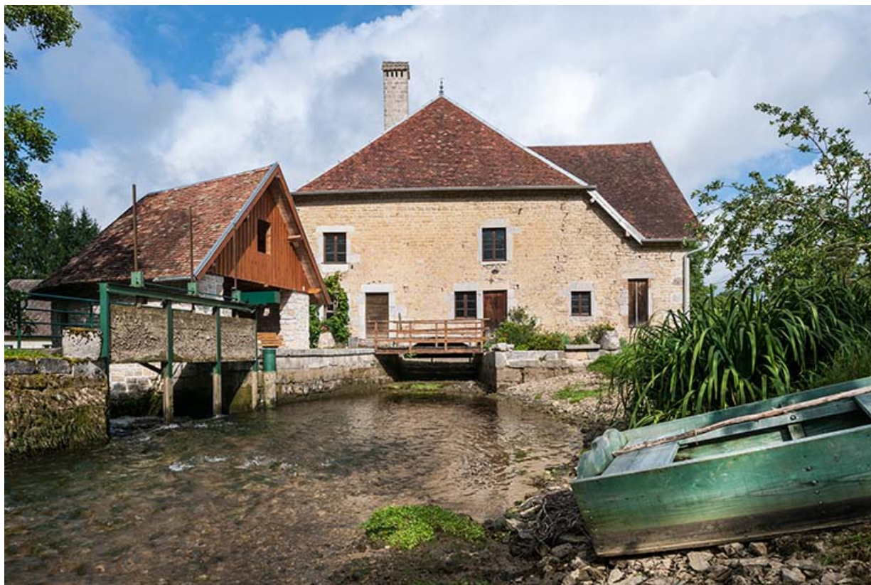
Vue rapprochée depuis le sud-est.
