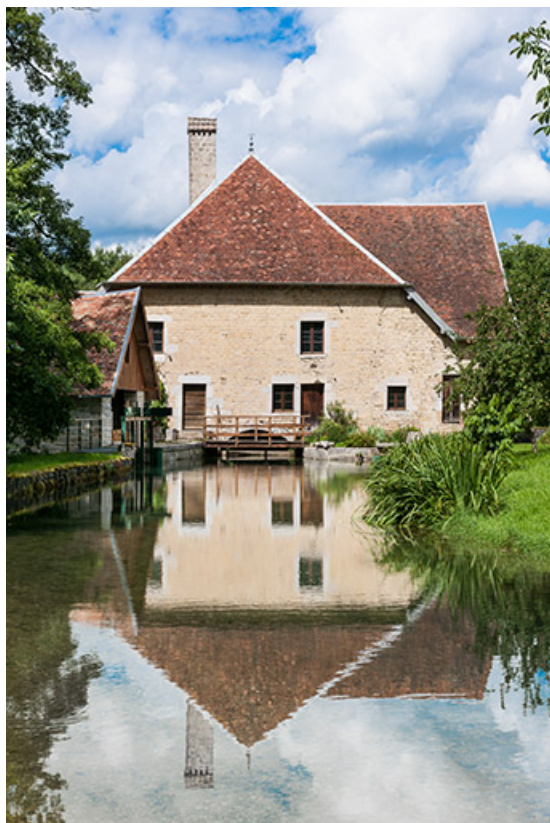
Vue d'ensemble depuis l'amont (cadrage vertical).
