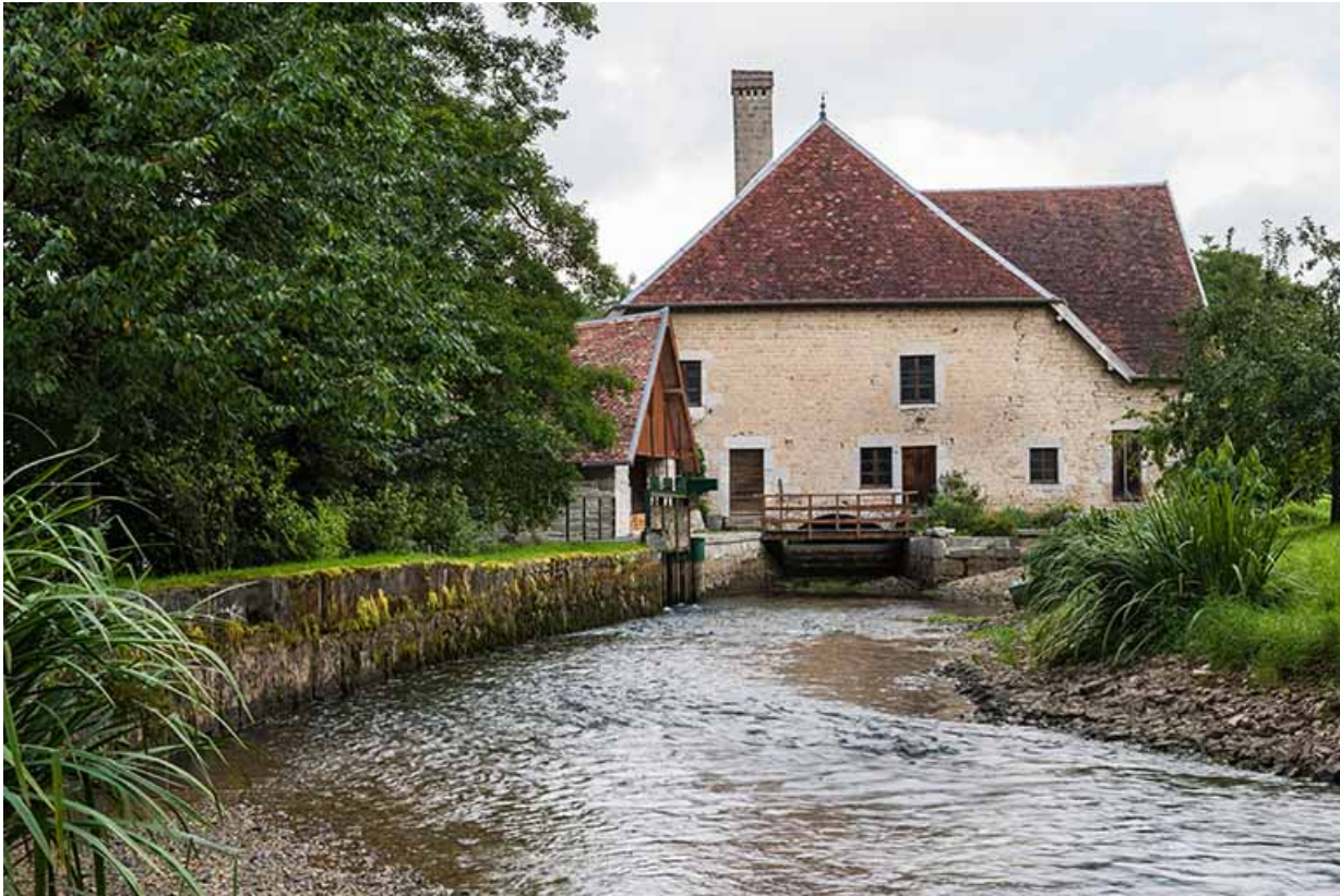
Vue depuis l'amont (canal d'amenée vidé). 25, Bremondans, lieudit : Amans
