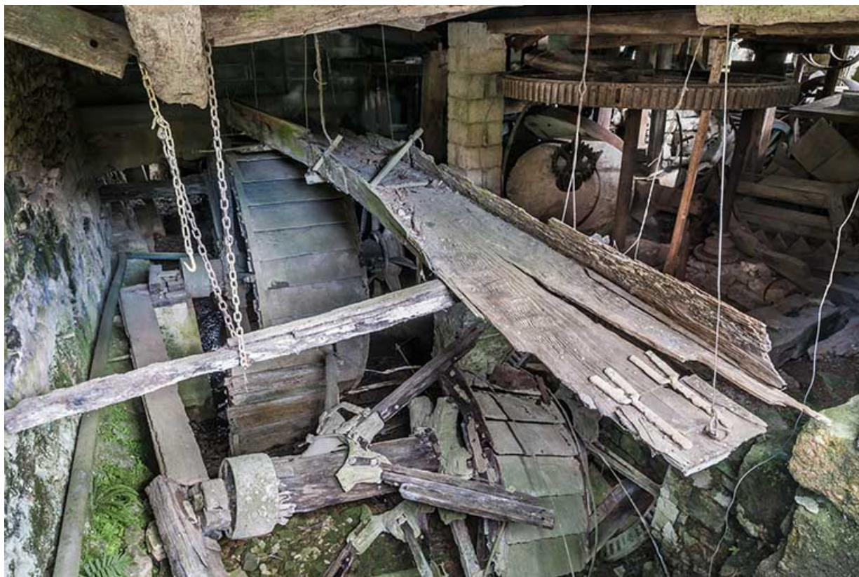
Vue plongeante sur la partie motrice : vestiges de deux roues hydrauliques et de la huche d'amenée. 25, Bremondans, lieudit : Amans
