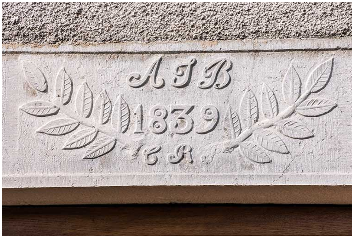
Détail du linteau de la porte (façade ouest).
