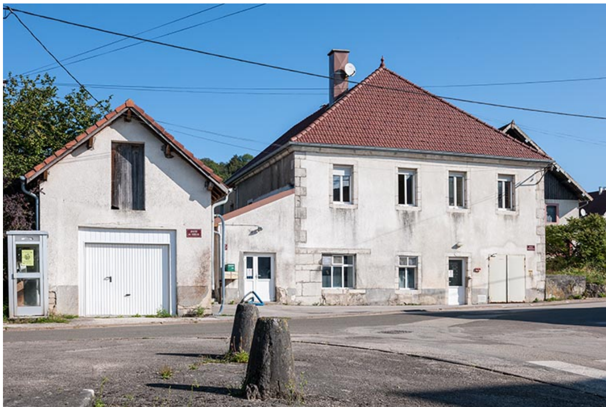
Façade antérieure depuis le sud.
