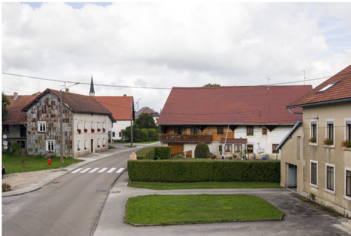
Vue d'ensemble, depuis le sud. Au centre la ferme Guigon-Cuenot et à droite l'atelier d'horlogerie Léon Cuenot et ses Fils. 25, Les Écorces, 20 Grande Rue
