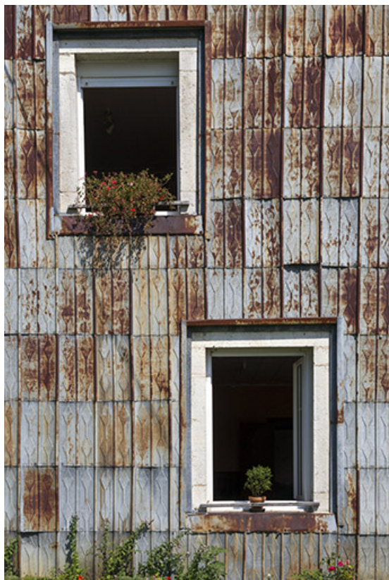
Façade latérale gauche : fenêtres et essentage de tôle. 25, Les Écorces, 20 Grande Rue
