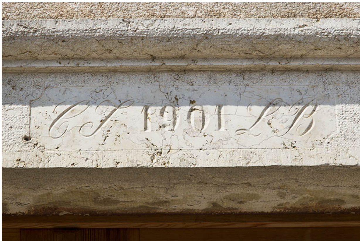
Façade antérieure : linteau daté.
