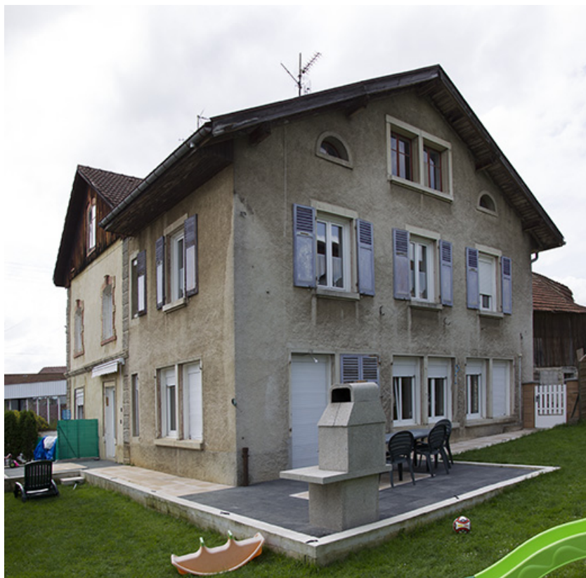
Logement patronal : façades postérieure et latérale droite.
