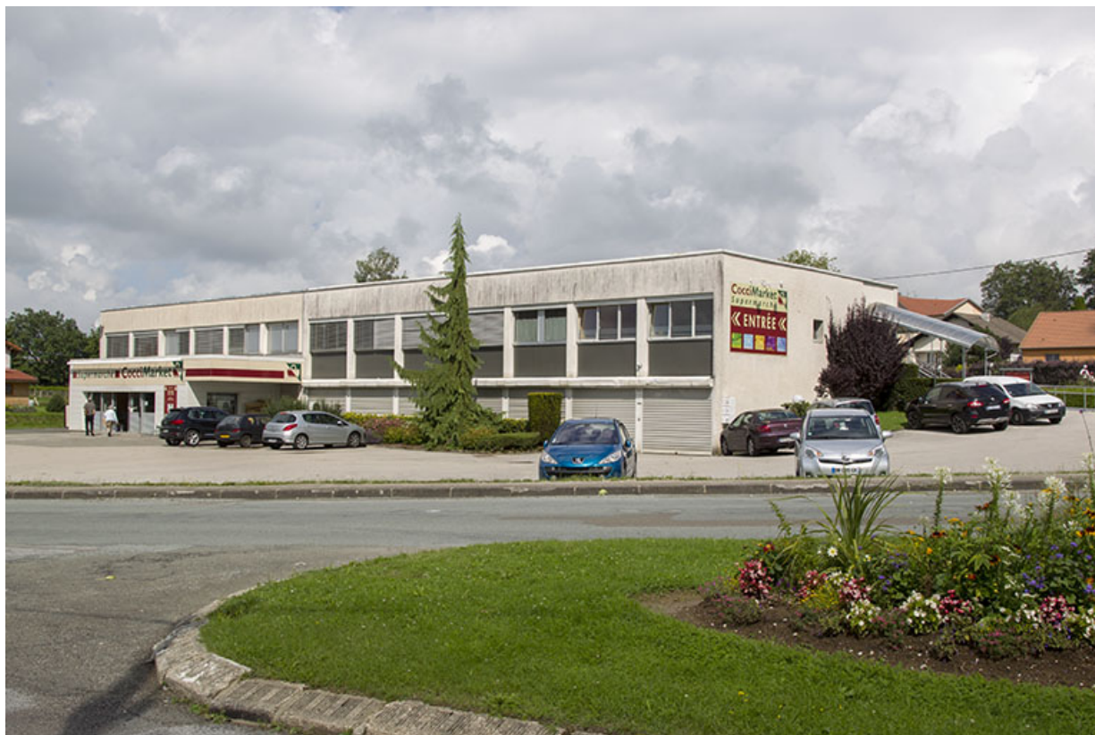
Une usine de 1975 (architecte Pierre Joly) et 1982 (Sanzio Ferraroli) : usine de montres Clyda (2 rue des Armaillis). 25, Charquemont, 2 rue des Armaillis
