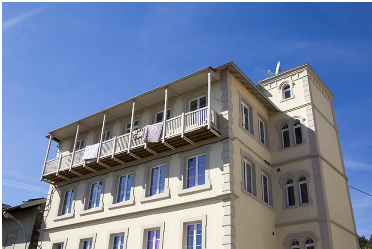
Usine, façade antérieure : étages et balcon.
