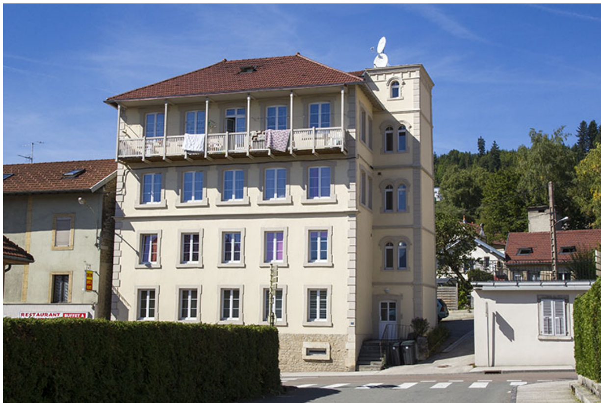
Usine : façade antérieure, de trois quarts droite.
