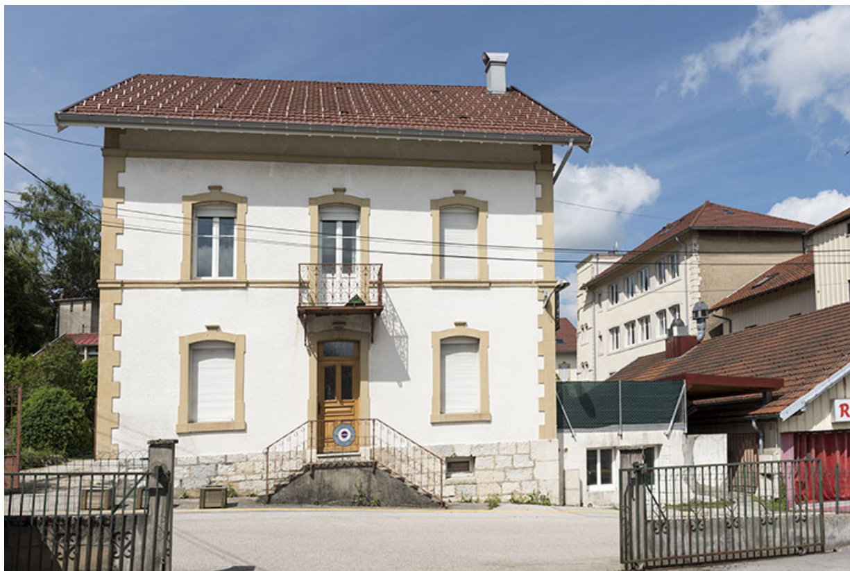
Maison chemin des Acacias : façade antérieure.
