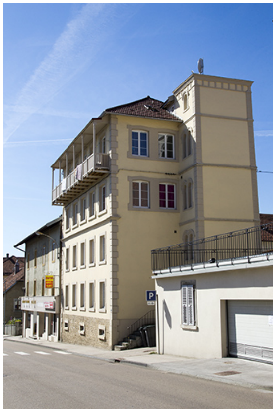
Usine : façades antérieure et latérale droite.
