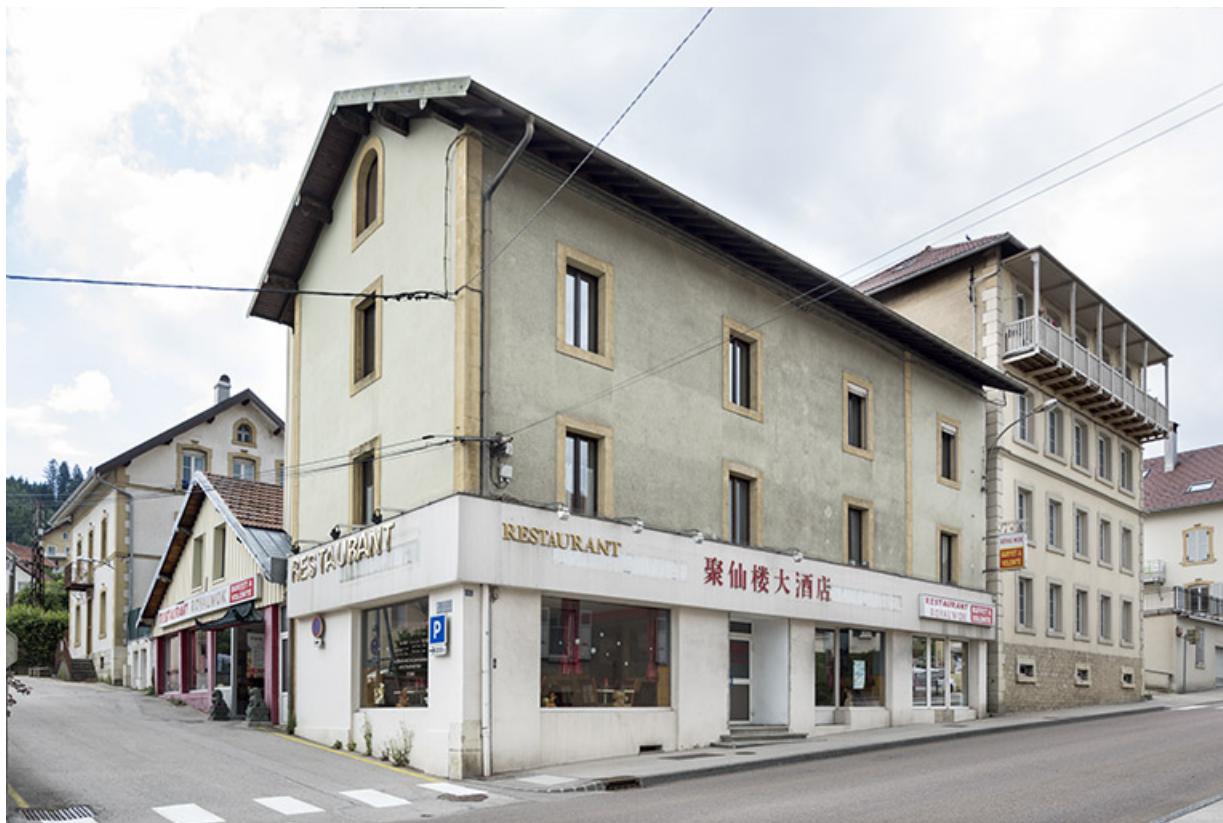
Vue d'ensemble depuis le sud 25, Morteau, 15 rue de la Louhière
