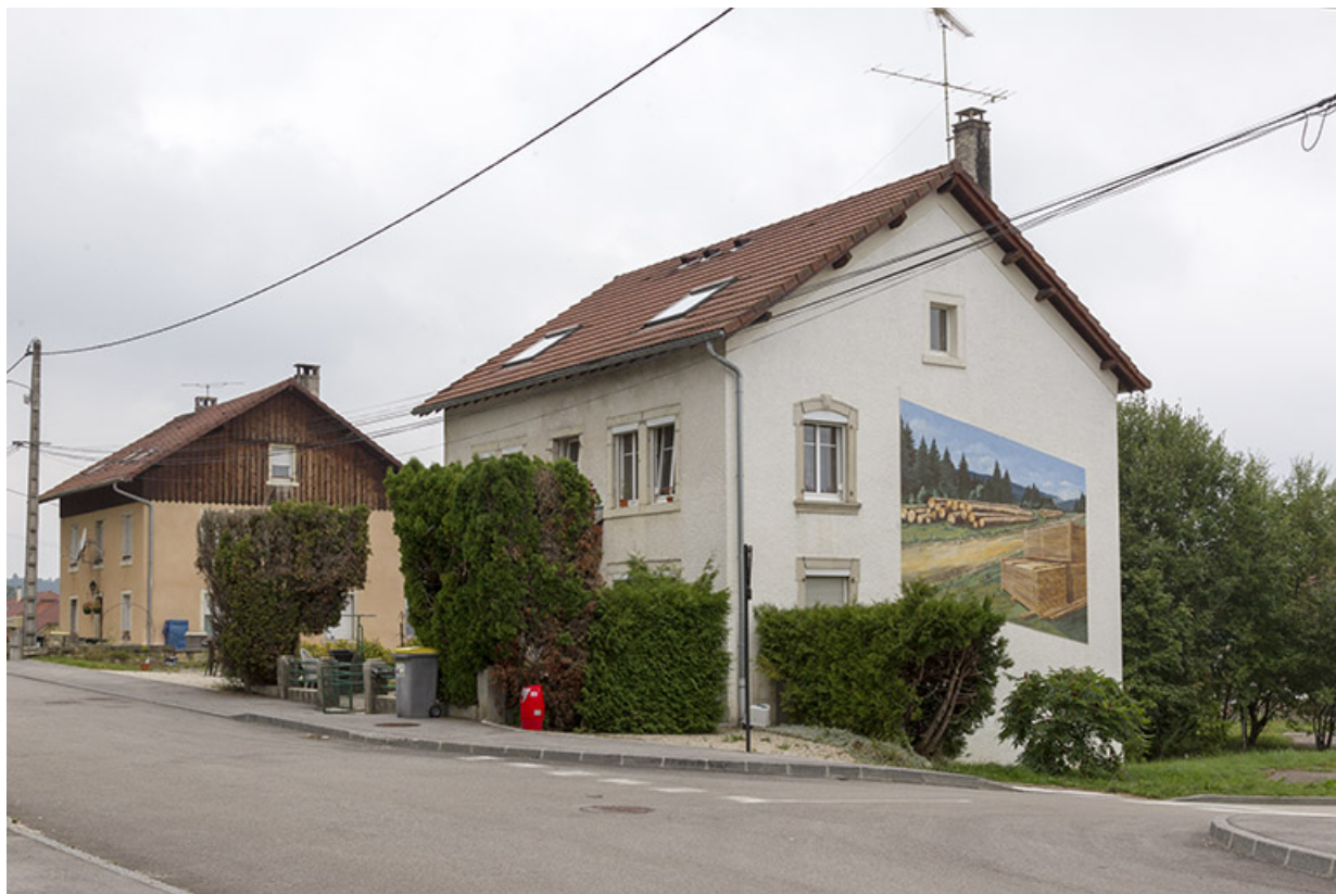
Logement patronal : vue d'ensemble, depuis l'est (façades antérieure et latérale droite). 25, Charquemont, 16 Rue Neuve
