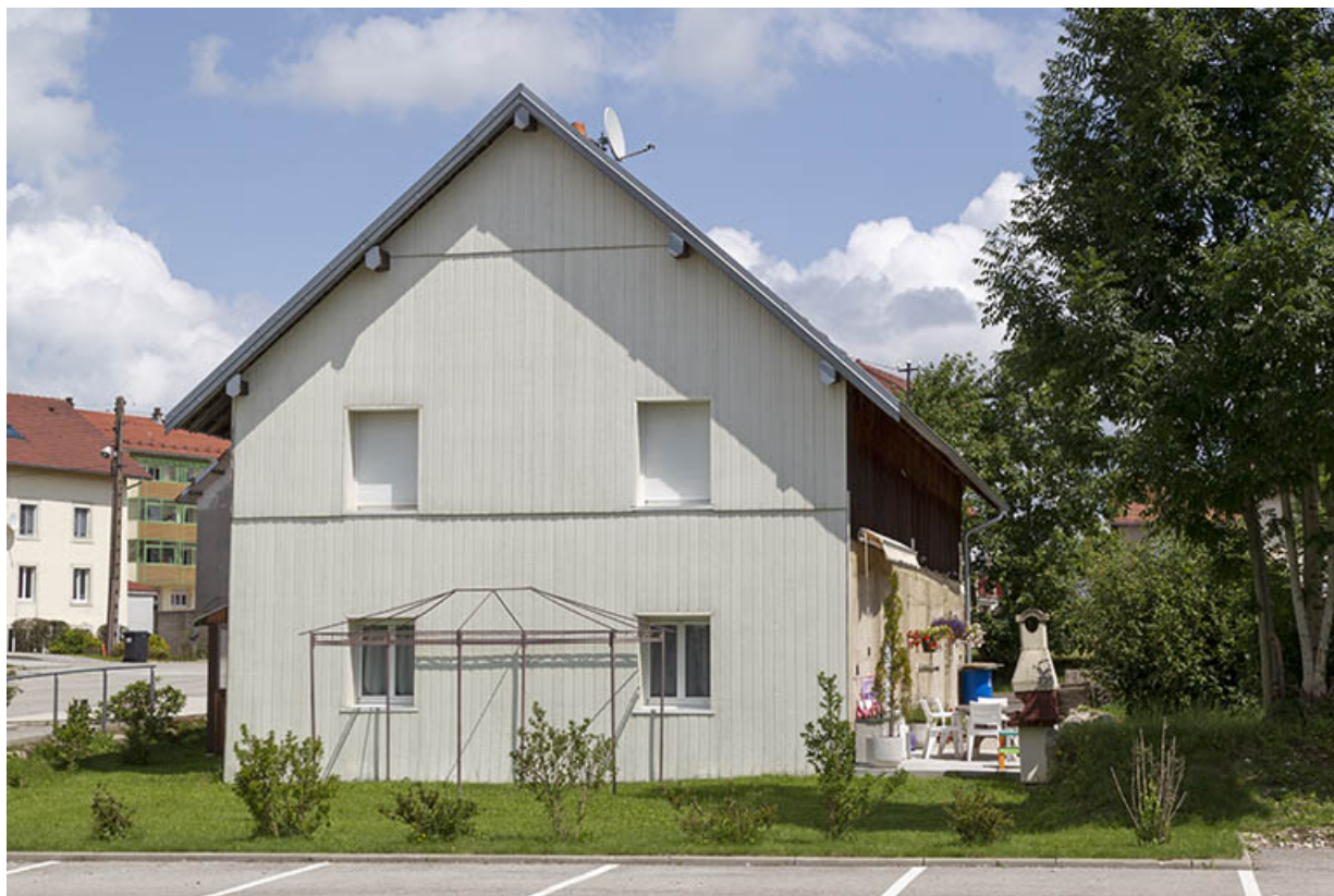
Logement d'ouvriers et dépôt de sciure : façade ouest.
