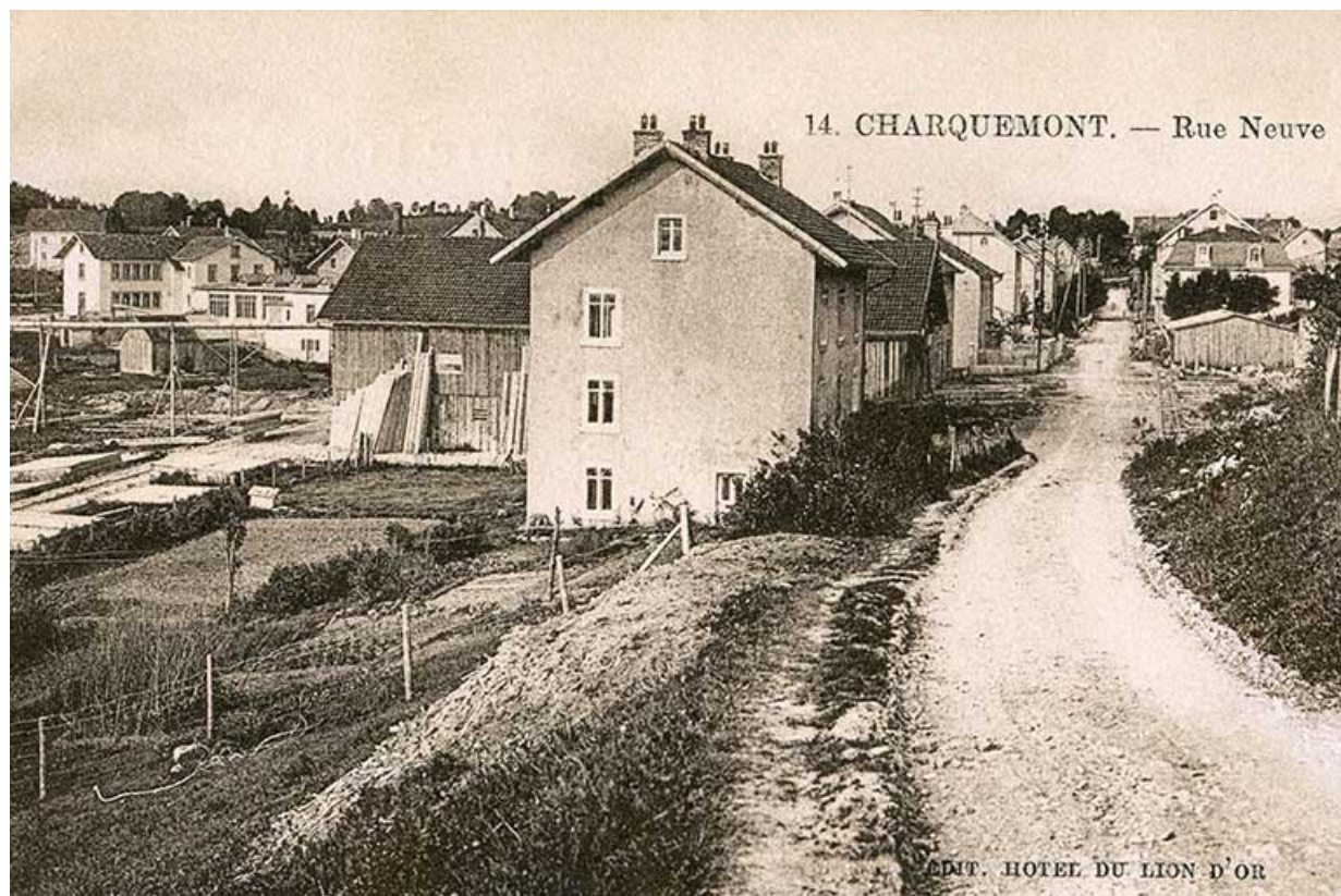
14. Charquemont. - Rue Neuve [vers la scierie], 2e quart 20e siècle 25, Charquemont, 16 Rue Neuve
