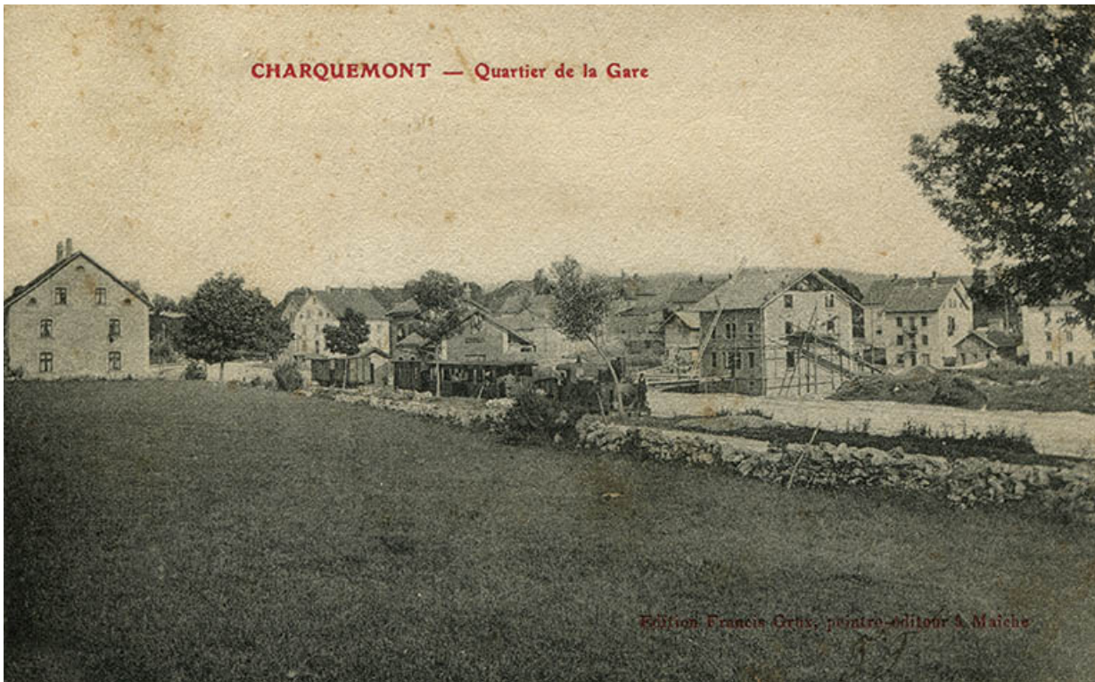
Charquemont - Quartier de la Gare, 1er quart 20e siècle. Le bâtiment est visible à droite. 25, Charquemont, 8 Rue Neuve
