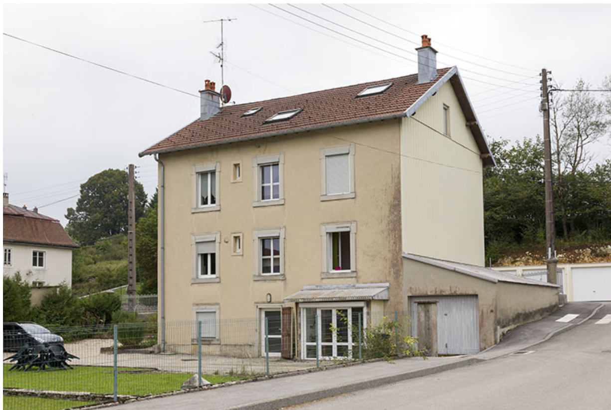
Façades postérieure et latérale gauche.
