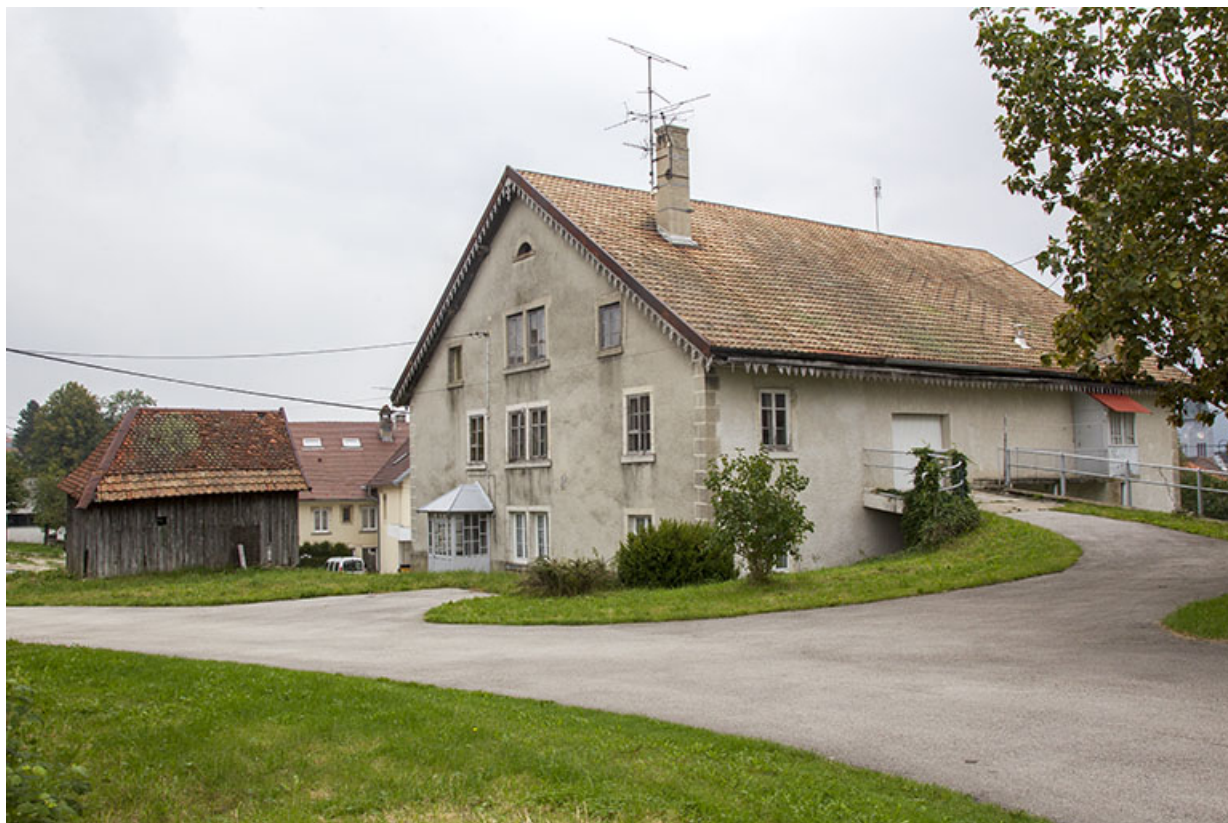
Vue d'ensemble, depuis l'ouest (façades postérieure et latérale droite). 25, Charquemont, 16 Grande Rue
