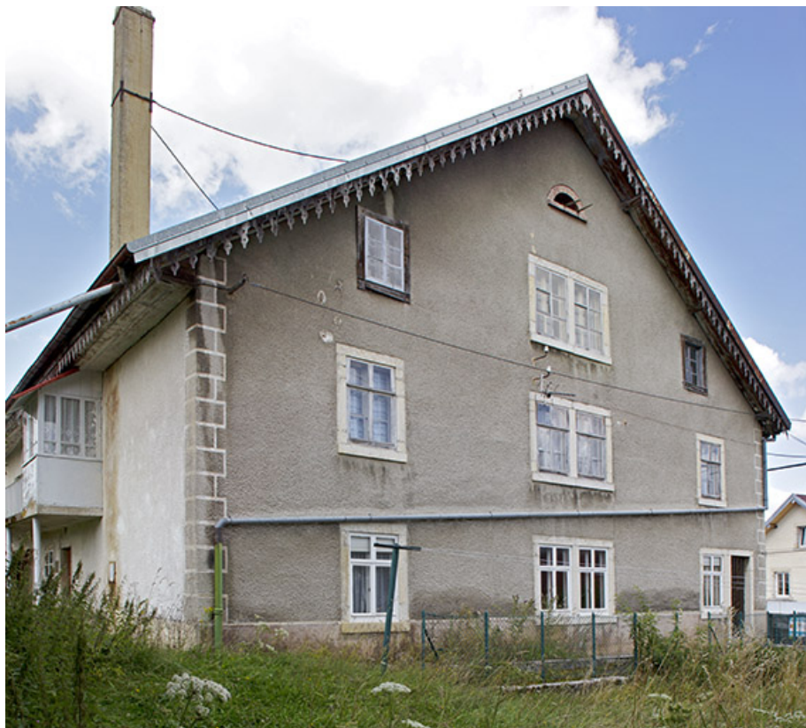
Façade latérale gauche.
