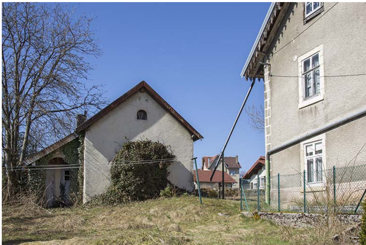
Tuyau d'alimentation de la citerne et dépendance.
