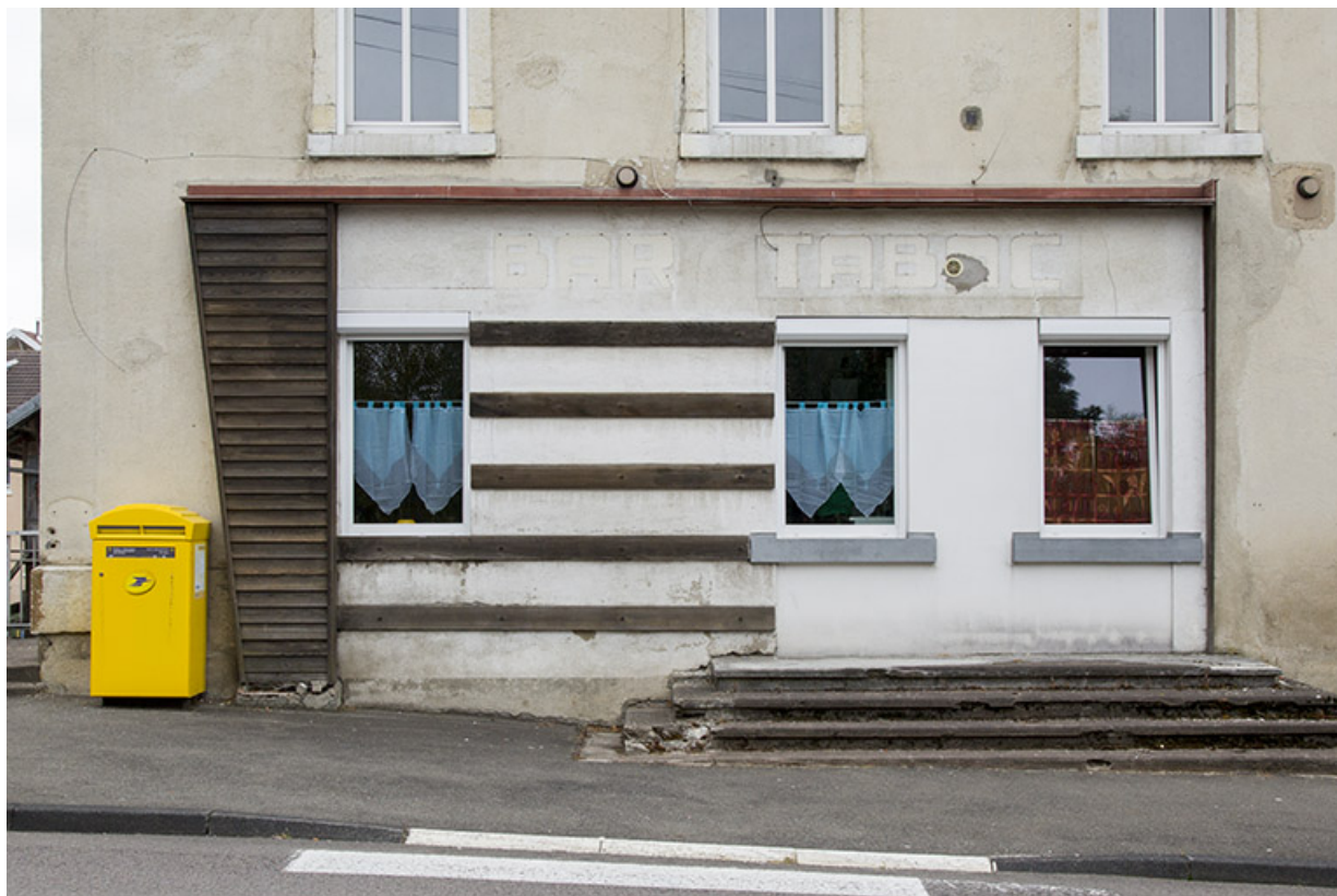
Façade latérale gauche en 2012 (avant rénovation) : ancienne devanture de commerce. 25, Charquemont, 1 rue de la Gare
