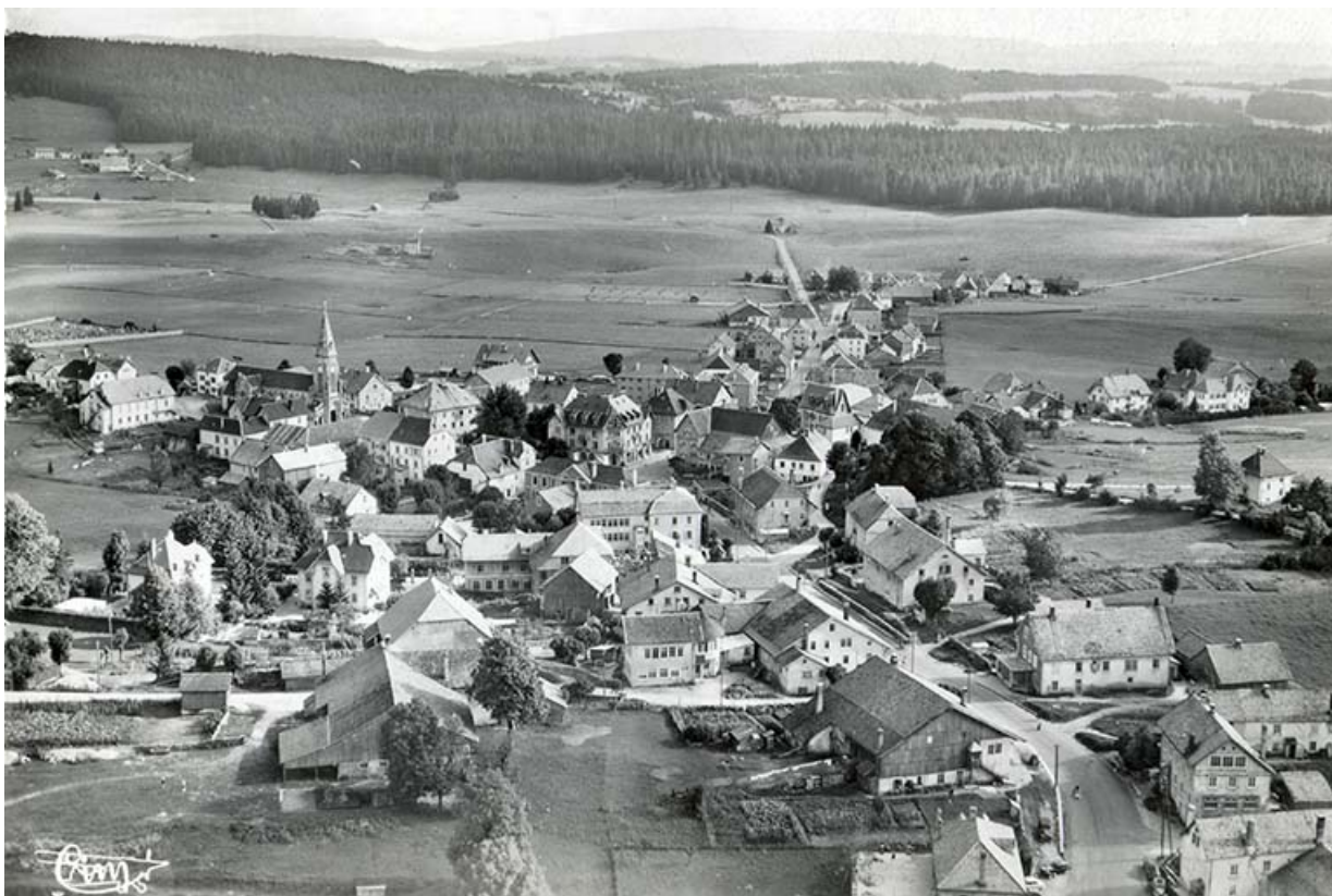
Charquemont (Doubs). 11059 - Vue aérienne [depuis l'ouest], entre 1950 et 1955. La levée de grange est encore visible. 25, Charquemont, 3 et 3 bis rue du Général Leclerc
