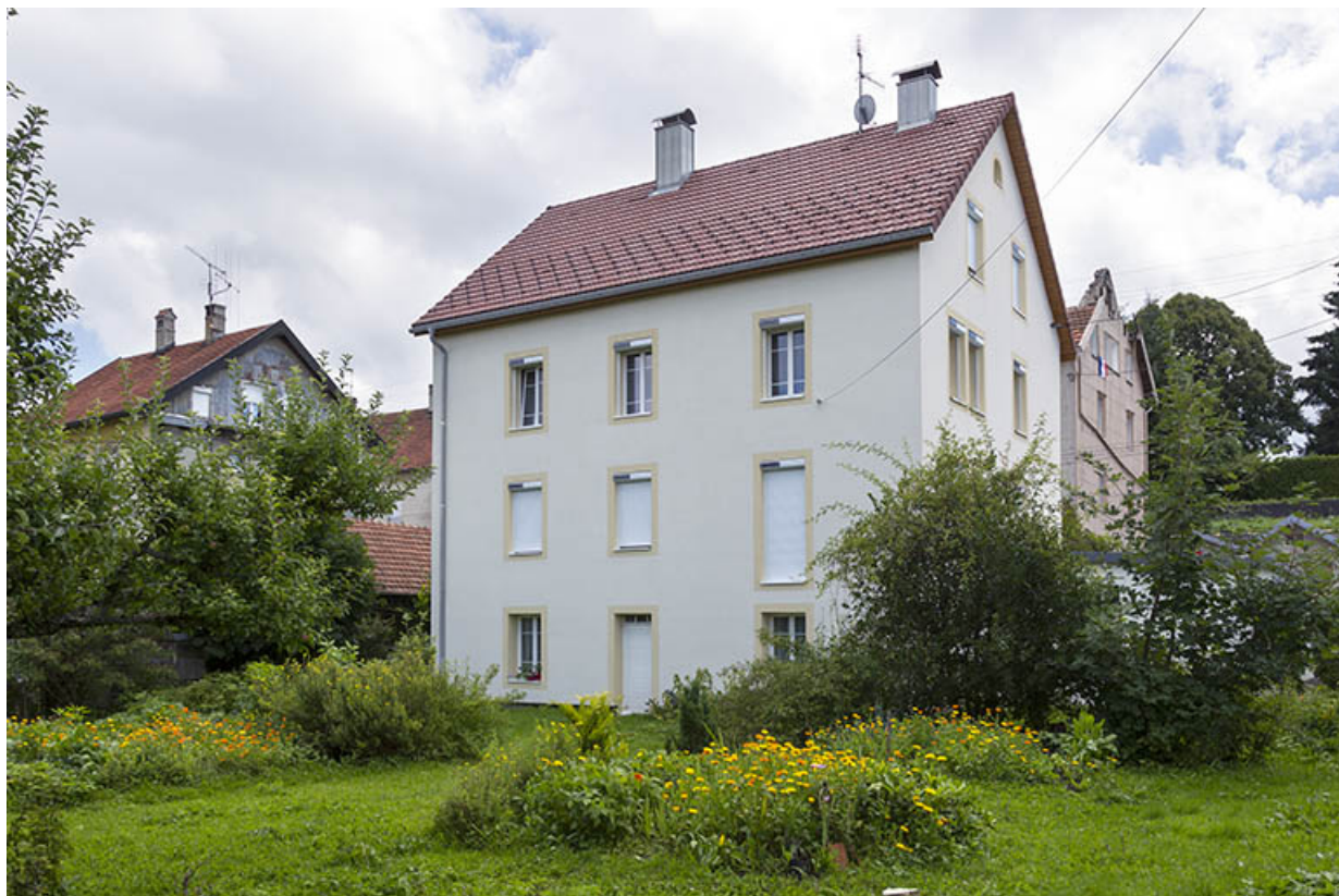
Façades postérieure et latérale gauche.
