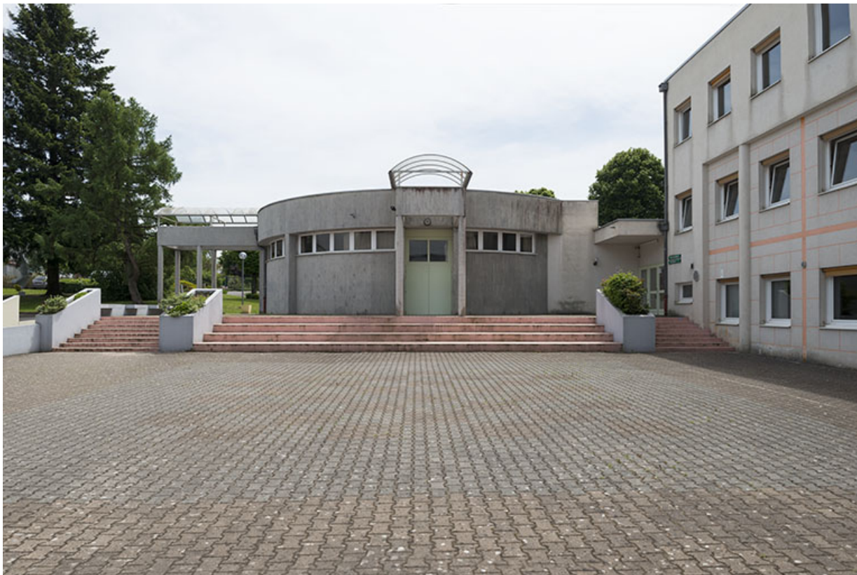
La cour, face à la façade nord de la salle polyvalente.
