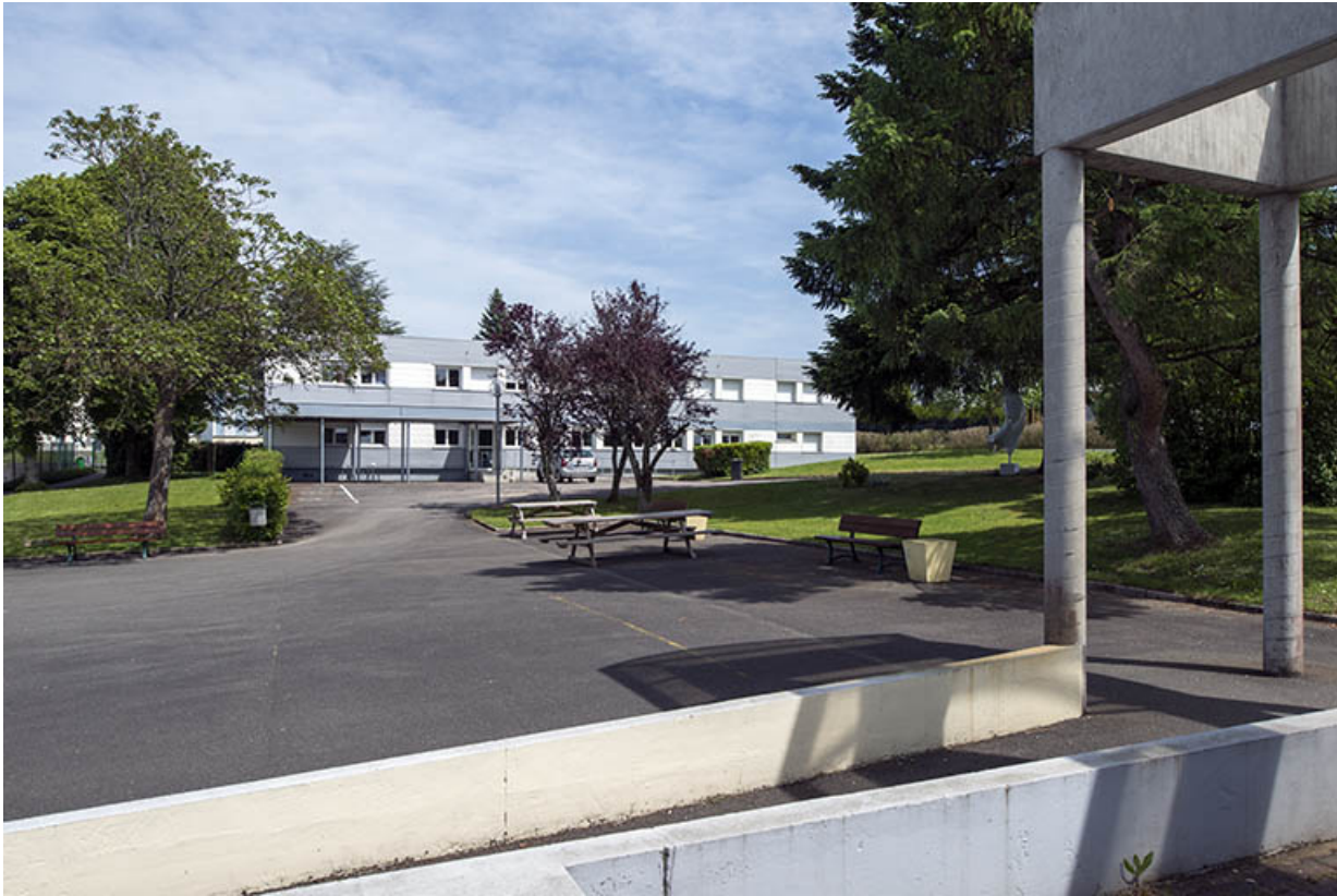
Face à l'administration, depuis l'ouest. 25, Bethoncourt impasse Camus
