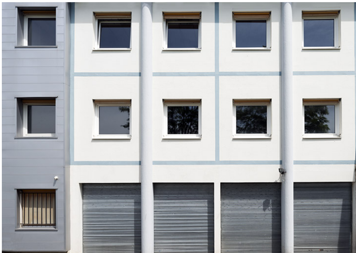
Détail de façade postérieure ouest de l'externat ouest.
