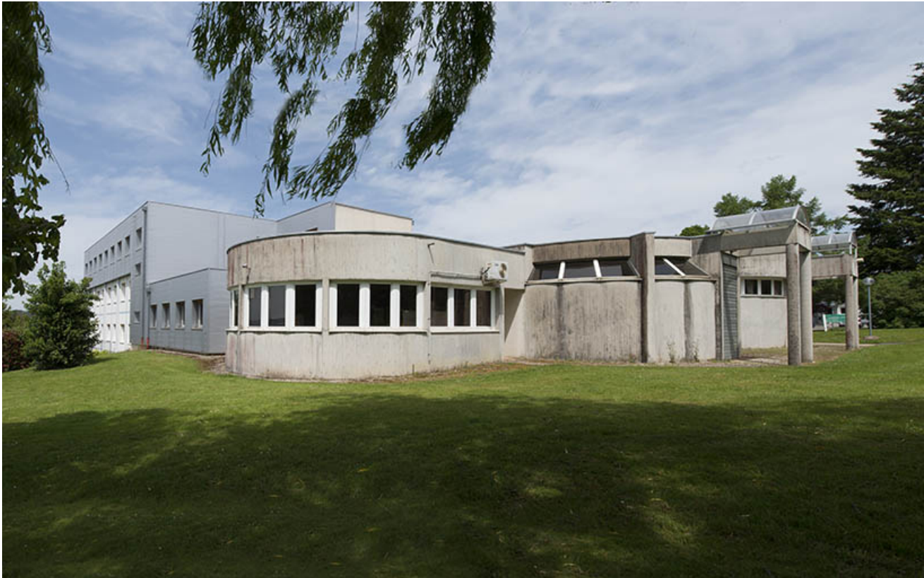
Extrémité sud-ouest des bâtiments d'externat et façade ouest.
