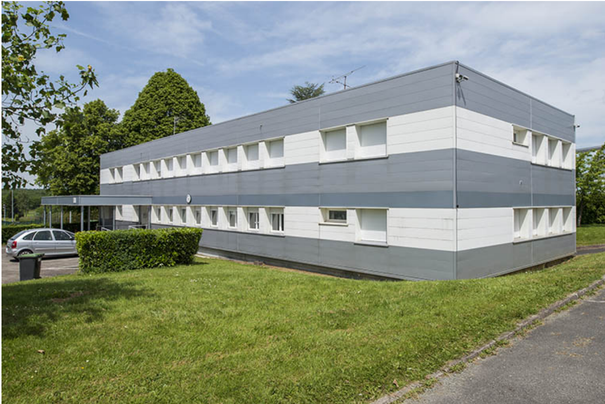
Angle sud-ouest, façade antérieure ouest d'entrée, pignon sud de l'administration. 25, Bethoncourt impasse Camus
