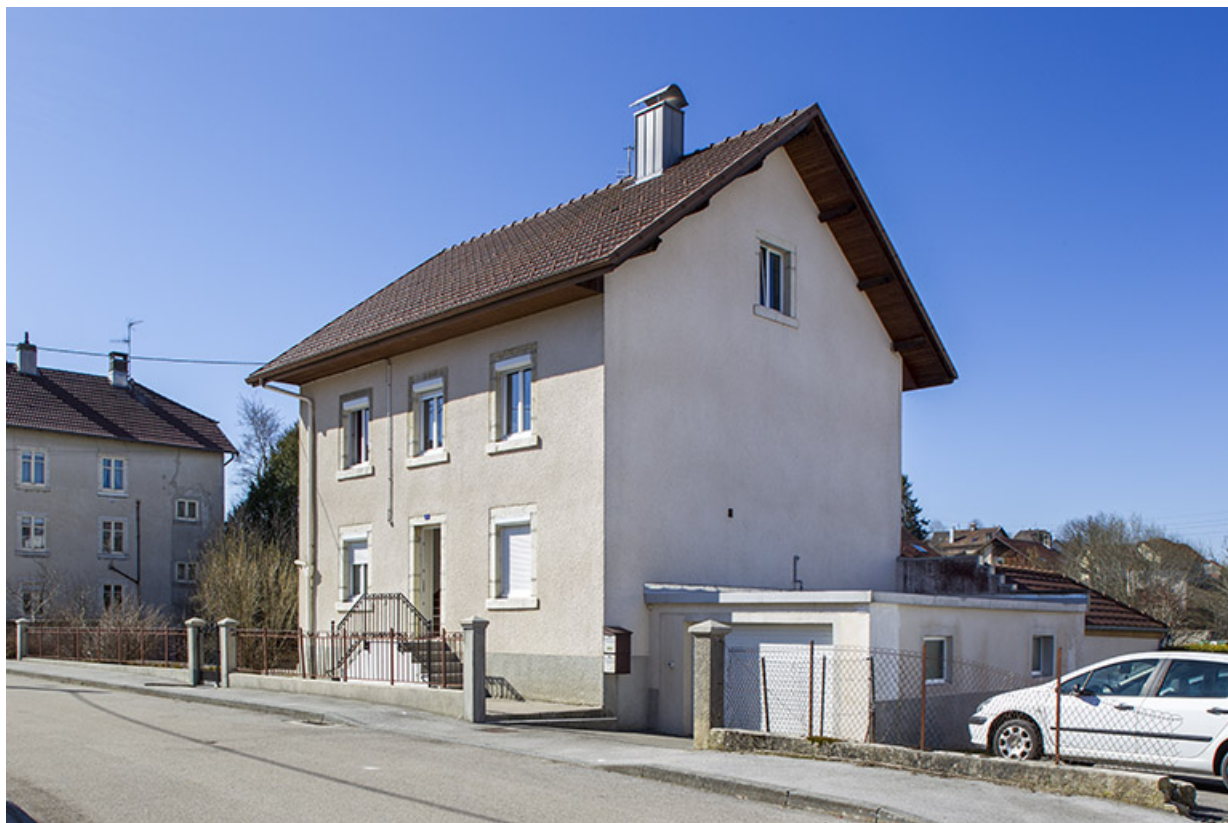
Vue d'ensemble, depuis le nord (façades antérieure et latérale droite). 25, Charquemont, 3 rue Pasteur
