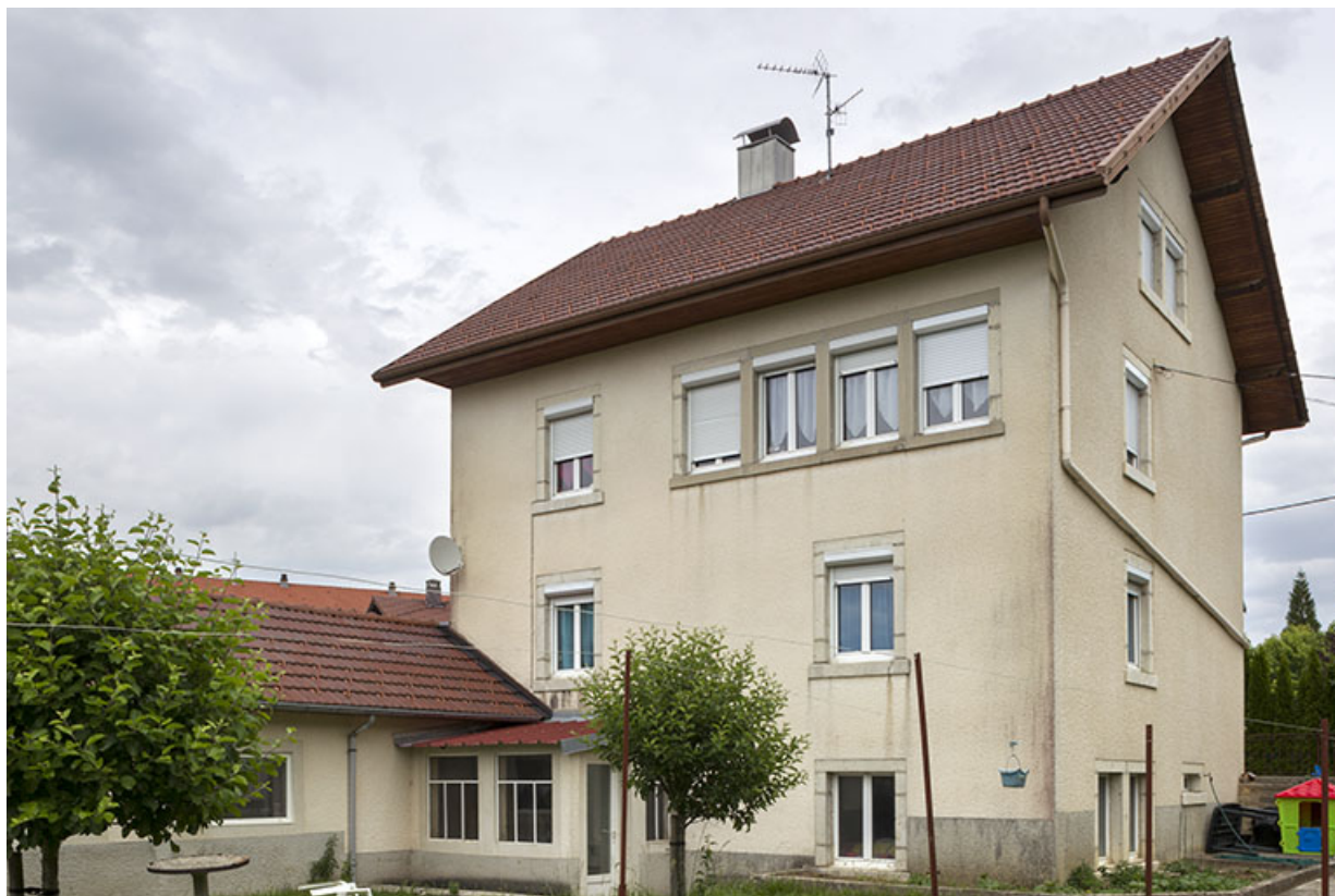
Vue d'ensemble, depuis le sud (façades postérieure et latérale gauche). 25, Charquemont, 3 rue Pasteur
