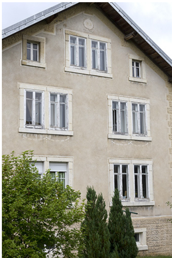
Façade latérale droite, de trois quarts gauche.
