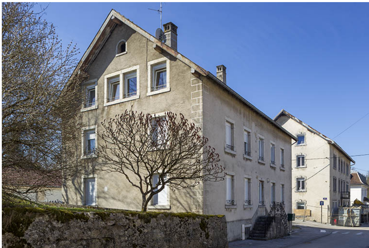
Façades antérieure et latérale gauche.
