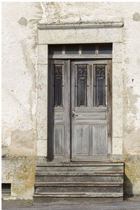
Façade antérieure : porte.
