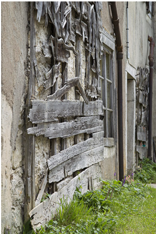
Façade postérieure : support de l'essentage de tavaillons, vu en enfilade. 25, Charquemont, 48 Grande Rue
