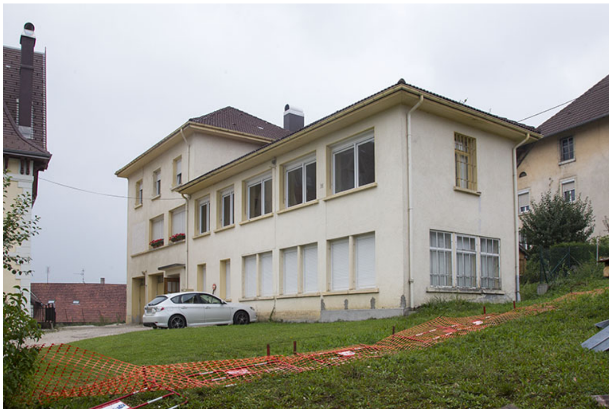
Usine, vue de trois quarts droite. A gauche, l'arrière du logement patronal. 25, Charquemont, 28 Grande Rue
