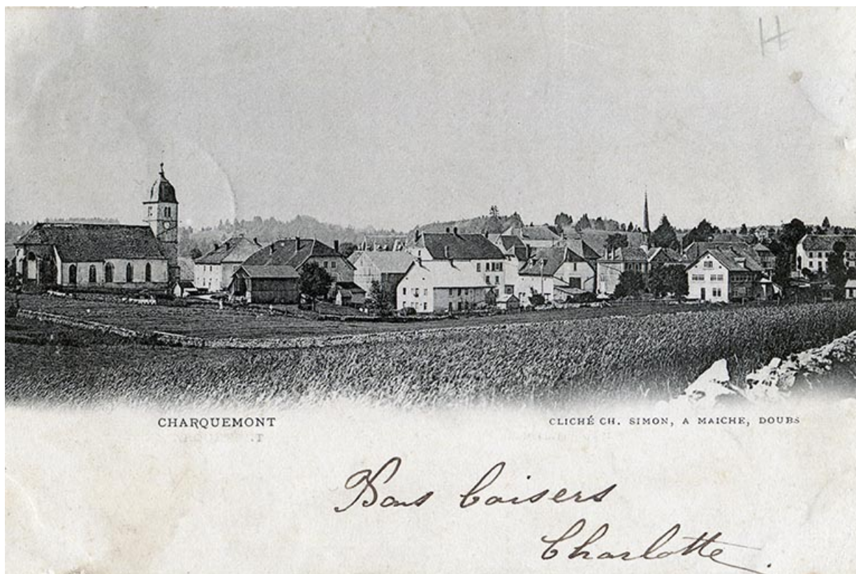
Charquemont [le quartier de l'église vu du nord], 4e quart 19e siècle (avant 1901). L'atelier de 1890 est visible à droite. 25, Charquemont, 5 et 6 place de l' Hôtel de Ville
