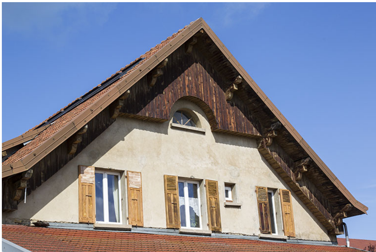
Façade postérieure : fenêtres du pignon.
