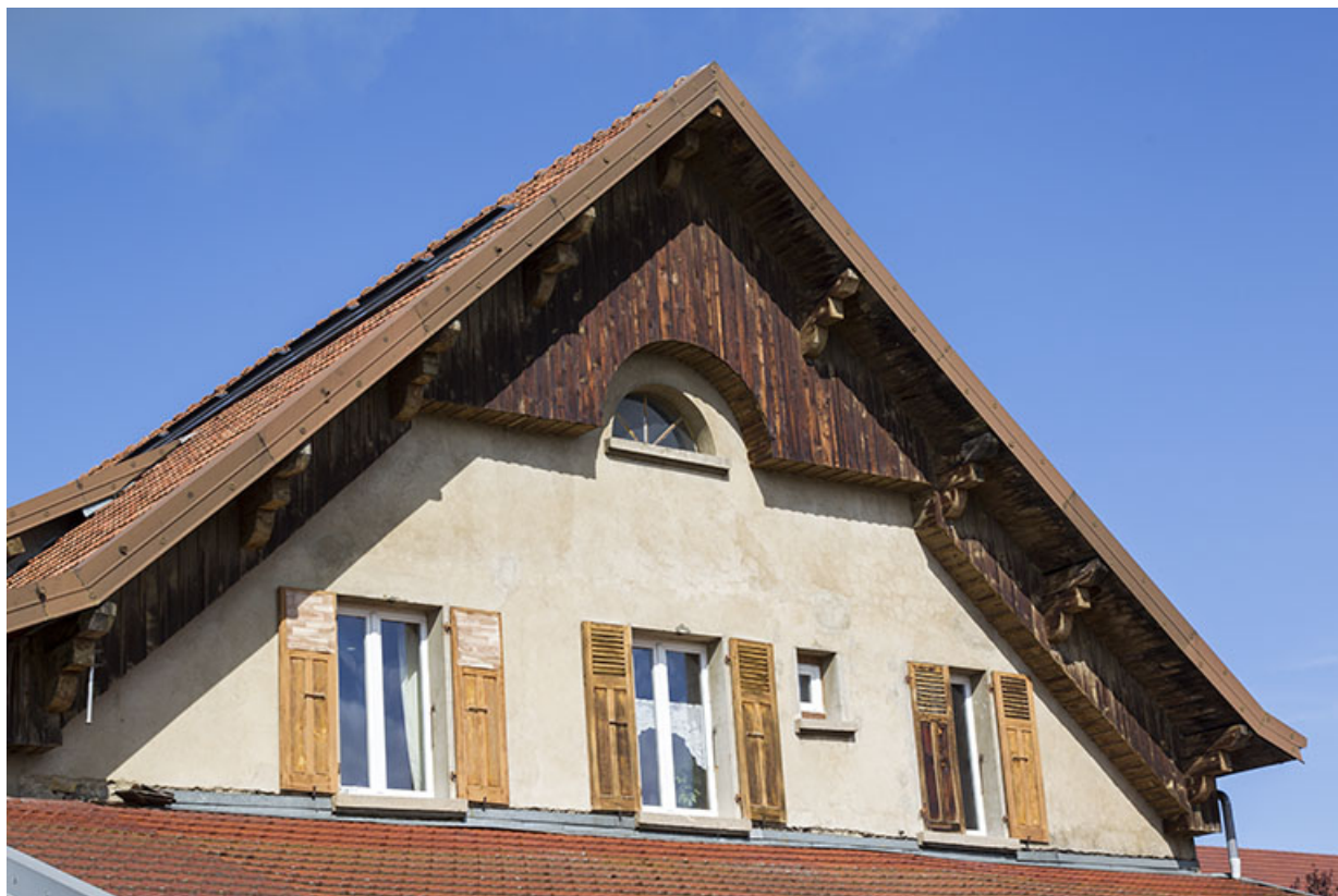
Façade postérieure : fenêtres du pignon.
