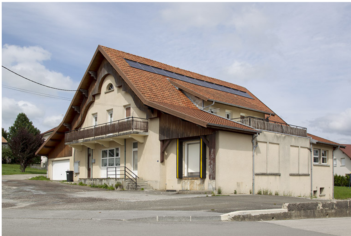
Façades antérieure et latérale droite.
