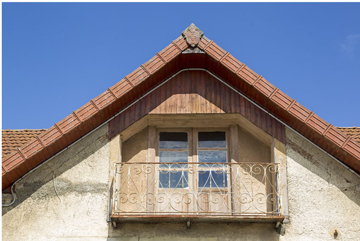
Façade antérieure : lucarne-pignon de l'étage en surcroît.
