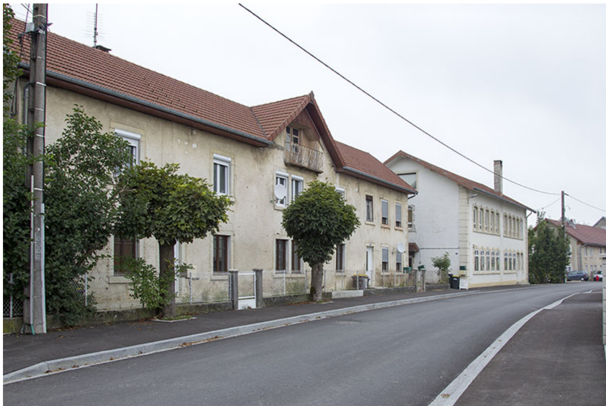
Vue d'ensemble, depuis le sud (façade antérieure).
