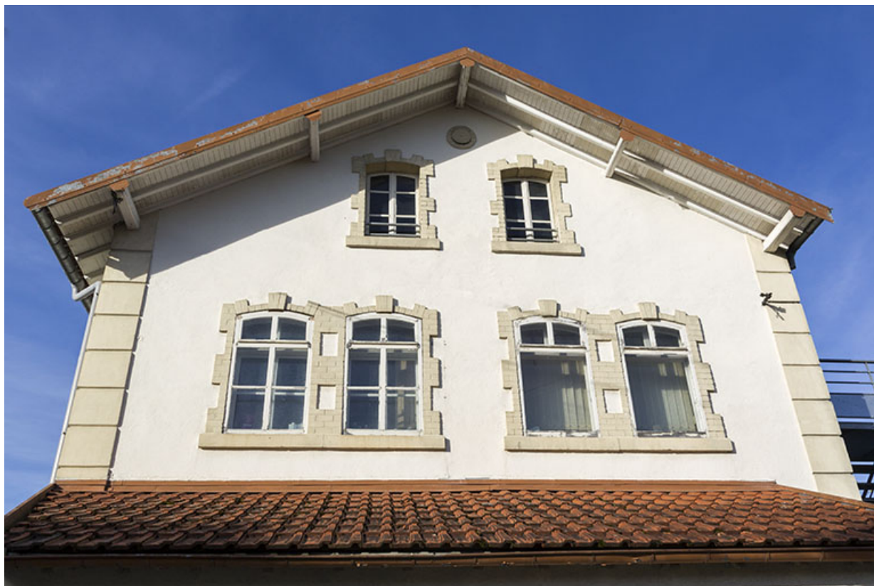
Façade latérale droite : fenêtres de niveaux supérieurs.
