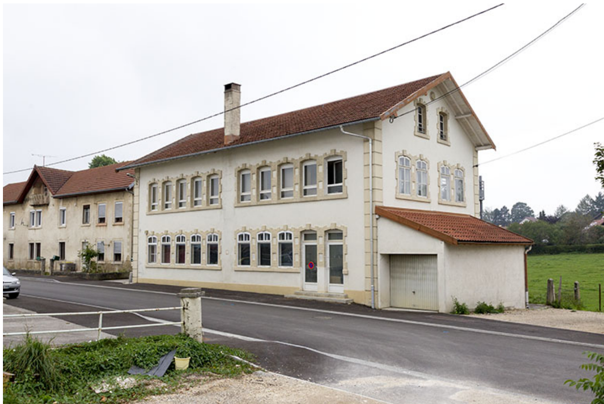
Vue d'ensemble, depuis le nord-est (façades antérieure et latérale droite). 25, Charquemont, 11 rue de l' Eglise
