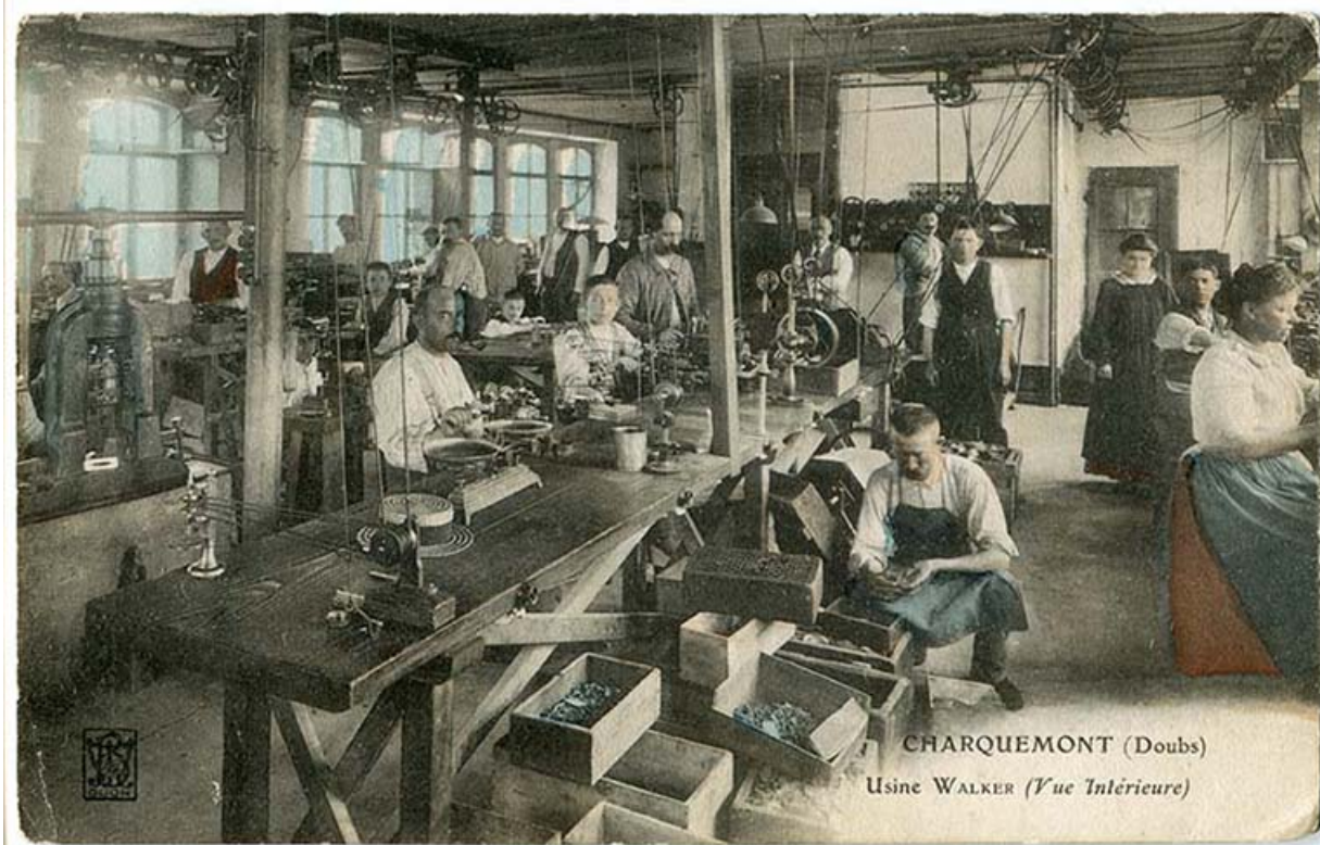
Intérieur d'une entreprise importante (usine de montres et de roues de cylindre puis d'ancre Walcker, 11 rue de l'Eglise) : Charquemont (Doubs) - Usine Walker (vue intérieure), entre 1904 et 1907. 25, Charquemont, 11 rue de l' Eglise
