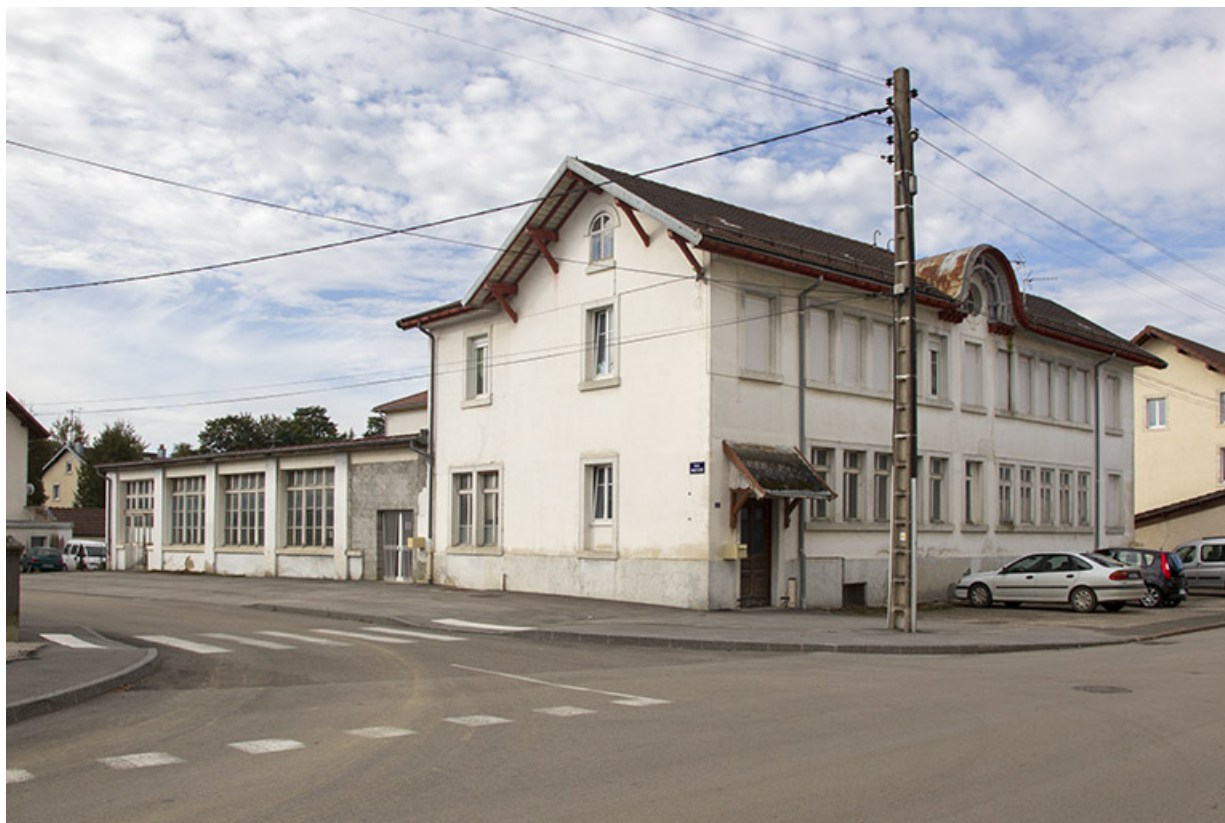
Vue d'ensemble, depuis le nord-est (façades antérieure et latérale gauche). 25, Charquemont, 13 rue de la Gare
