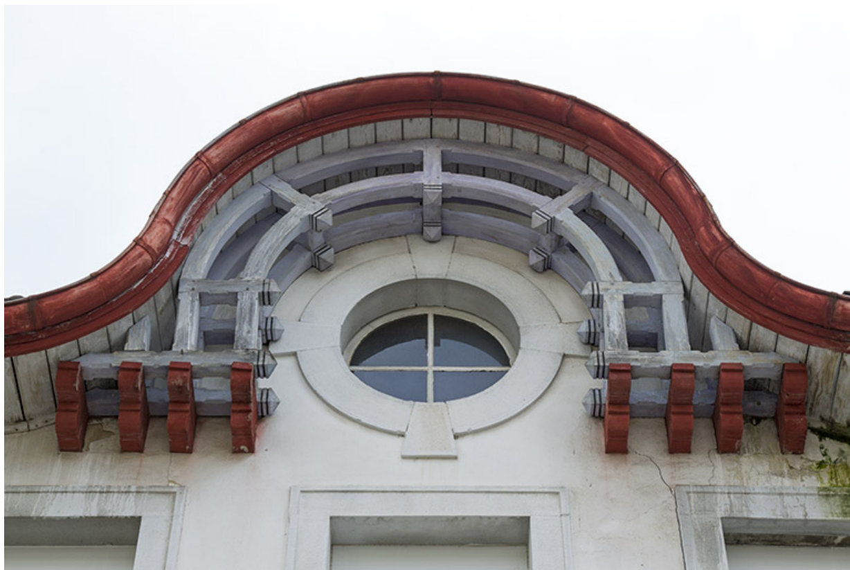
Façade antérieure : oculus vu en contre-plongée.
