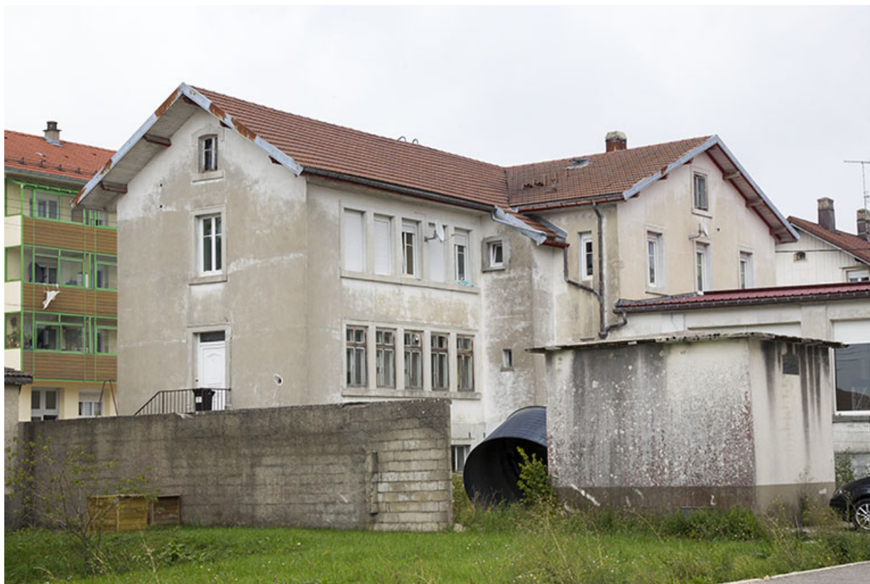
Façades postérieure et latérale droite.
