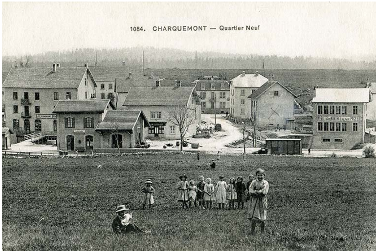
1084. Charquemont - Quartier Neuf, 1er quart 20e siècle 25, Charquemont, 12 Rue Neuve
