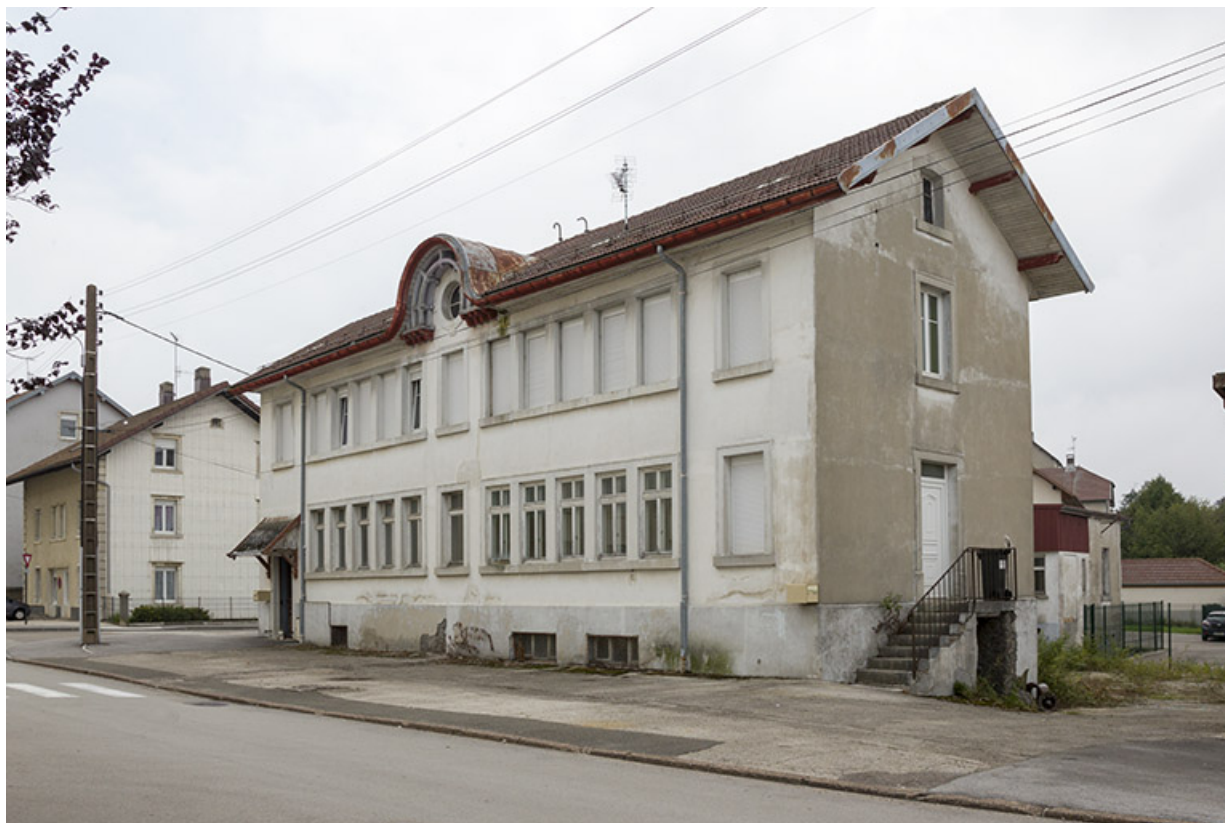
Façades antérieure et latérale droite.
