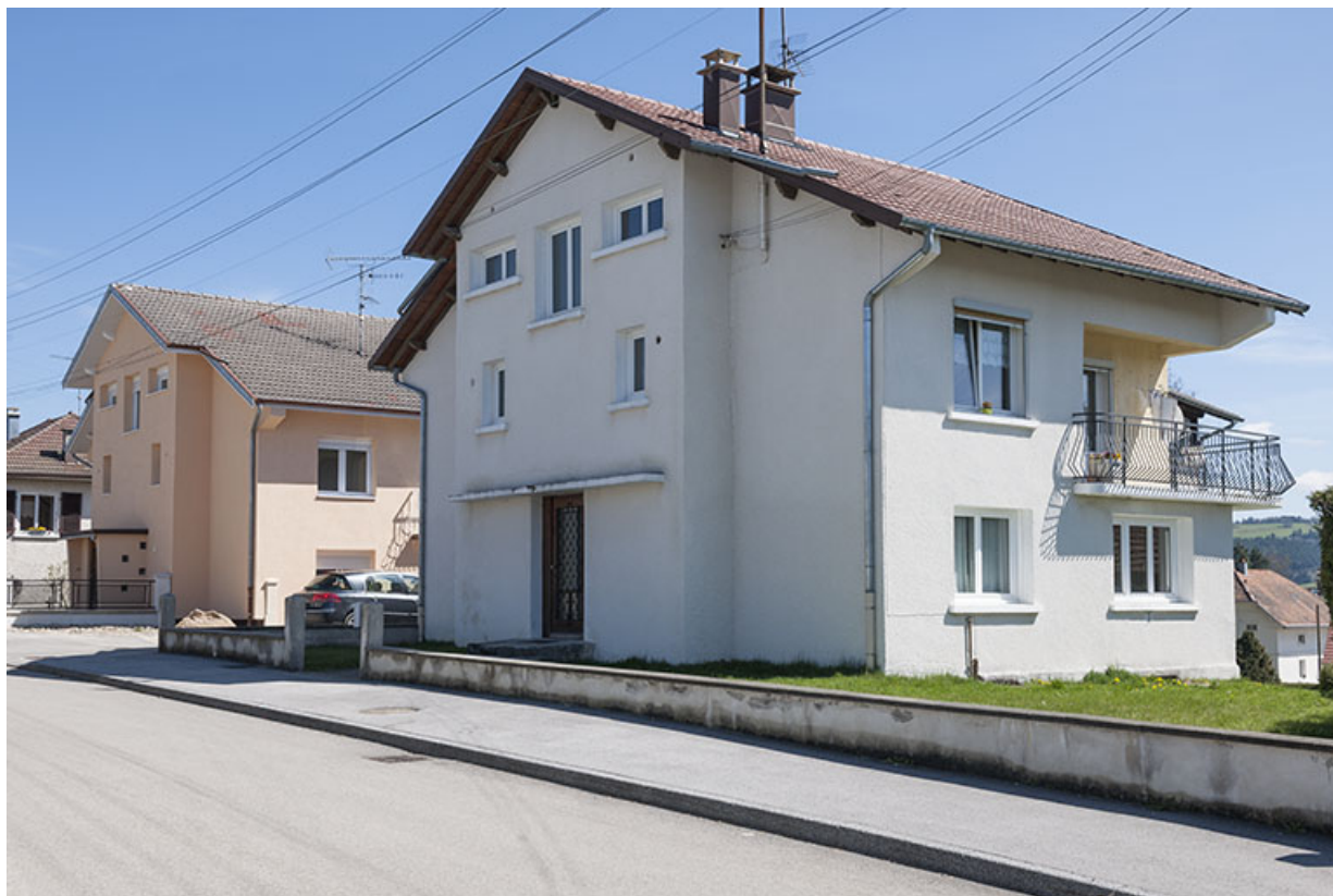
Deux maisons de 1957 avec leur atelier d'horlogerie : Jean et Marc Morel (2-4 rue de la 1ère Armée). 25, Charquemont, 2 et 4 rue de la 1ère Armée
