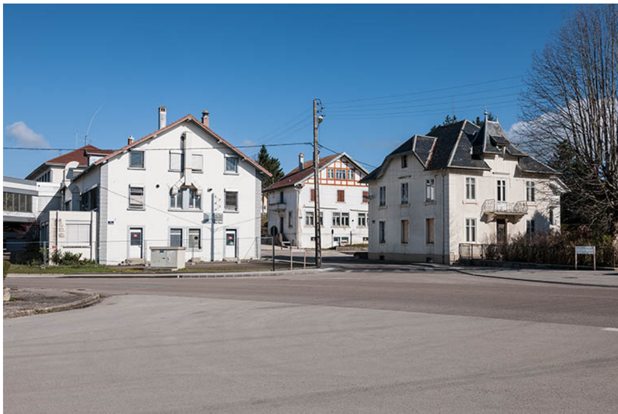
Maison, ateliers et usine de 1913 aux années 1990 : usine de cadrans de montre de la société Haenni / Elector (1-5 rue Victor Hugo). 25, Charquemont, 1-5 rue Victor Hugo
