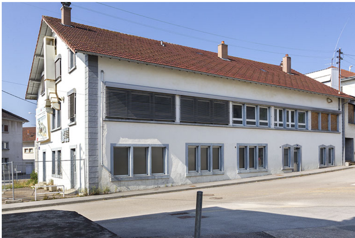
Usine, 1er corps de bâtiment : façade antérieure.
