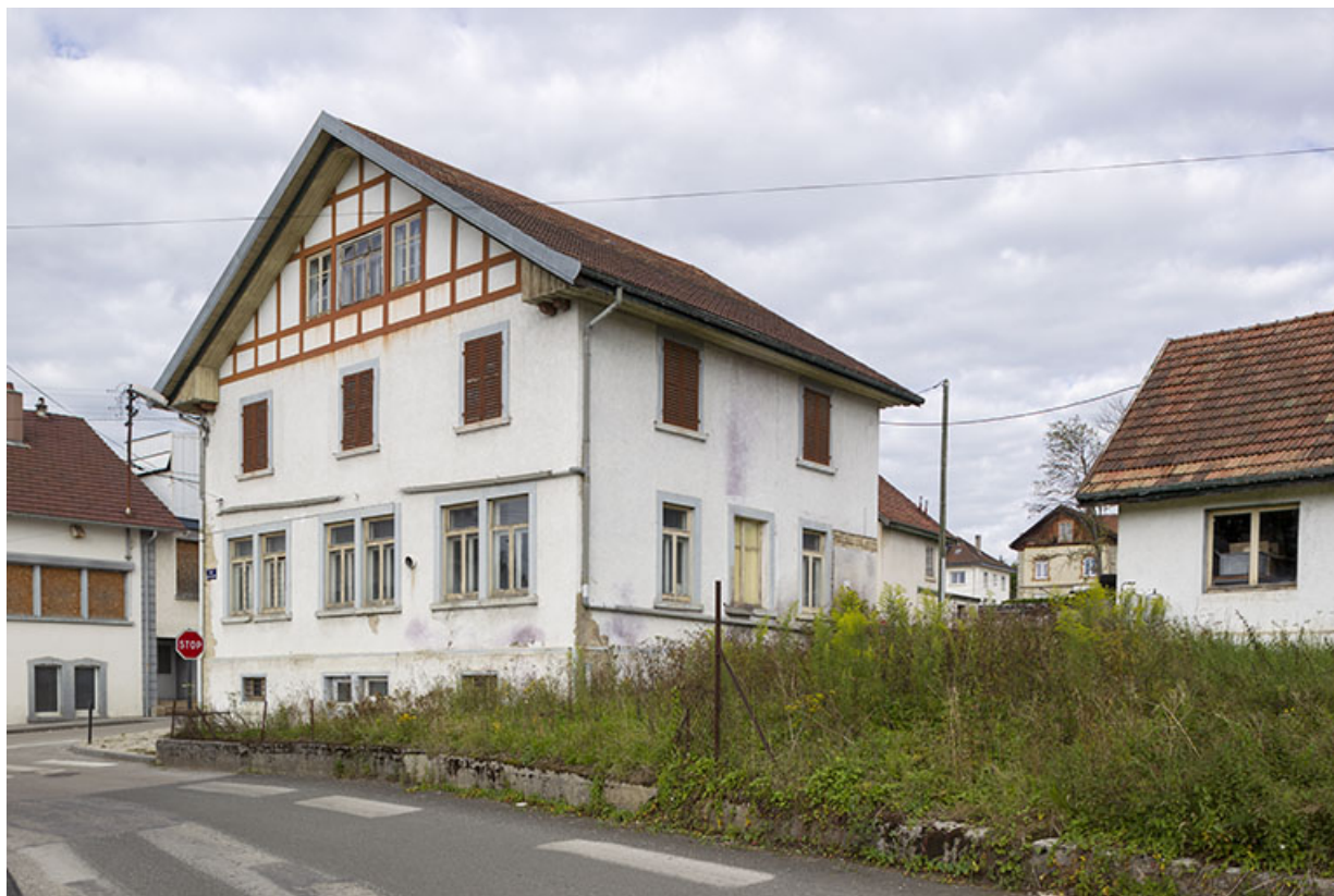
Deuxième bâtiment, au 4 rue Victor Hugo : façades antérieure et latérale droite. 25, Charquemont, 1-5 rue Victor Hugo
