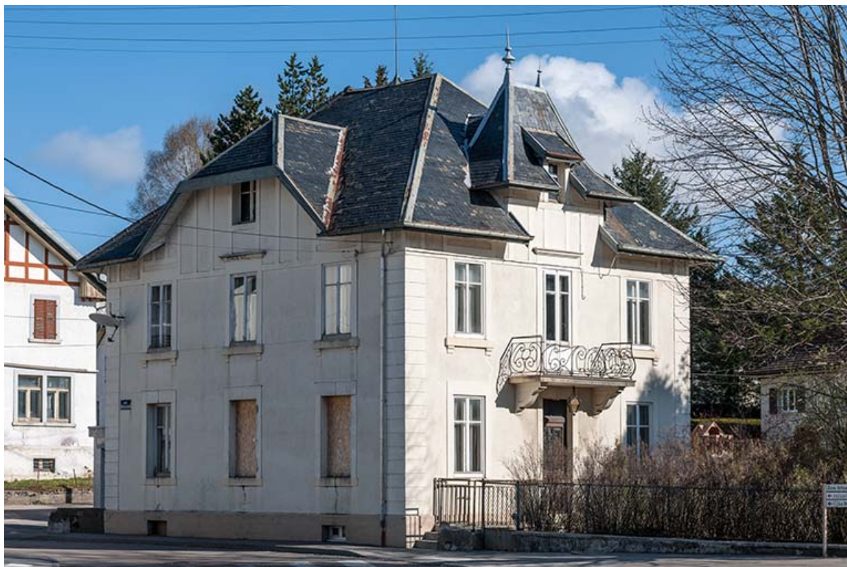
Premier bâtiment (logement patronal) au 2 rue Victor Hugo, vu du sud. 25, Charquemont, 1-5 rue Victor Hugo
