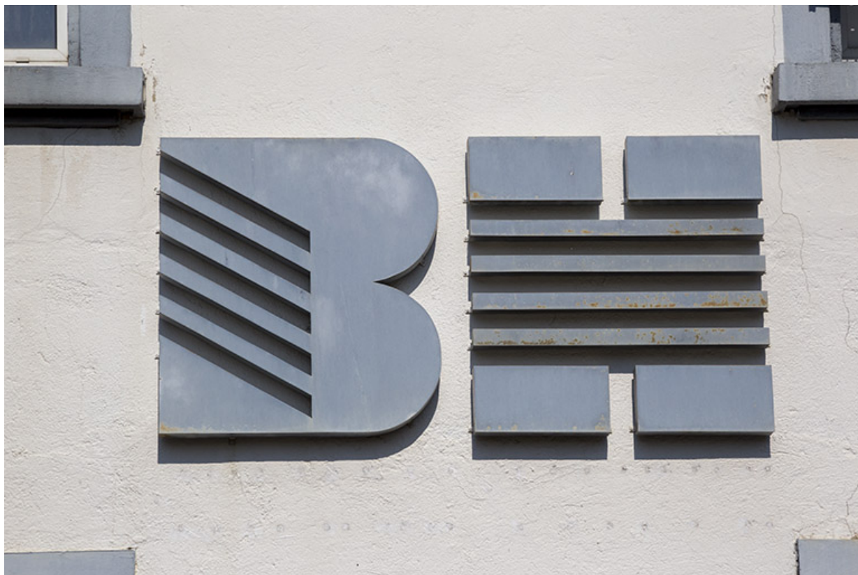
Usine, 1er corps de bâtiment : logotype de la société Bernard Haenni, sur la façade latérale gauche. 25, Charquemont, 1-5 rue Victor Hugo
