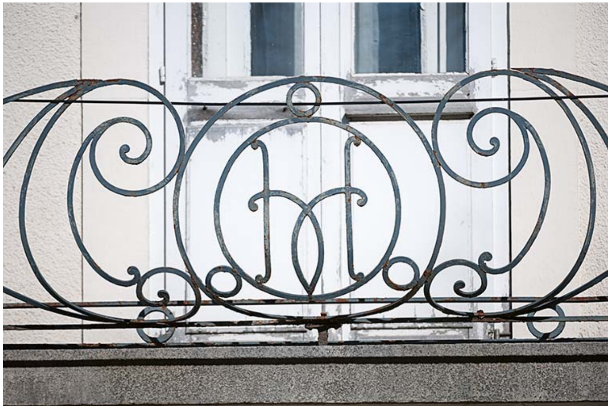
Premier bâtiment, au 2 rue Victor Hugo : monogramme sur la grille du balcon. 25, Charquemont, 1-5 rue Victor Hugo
