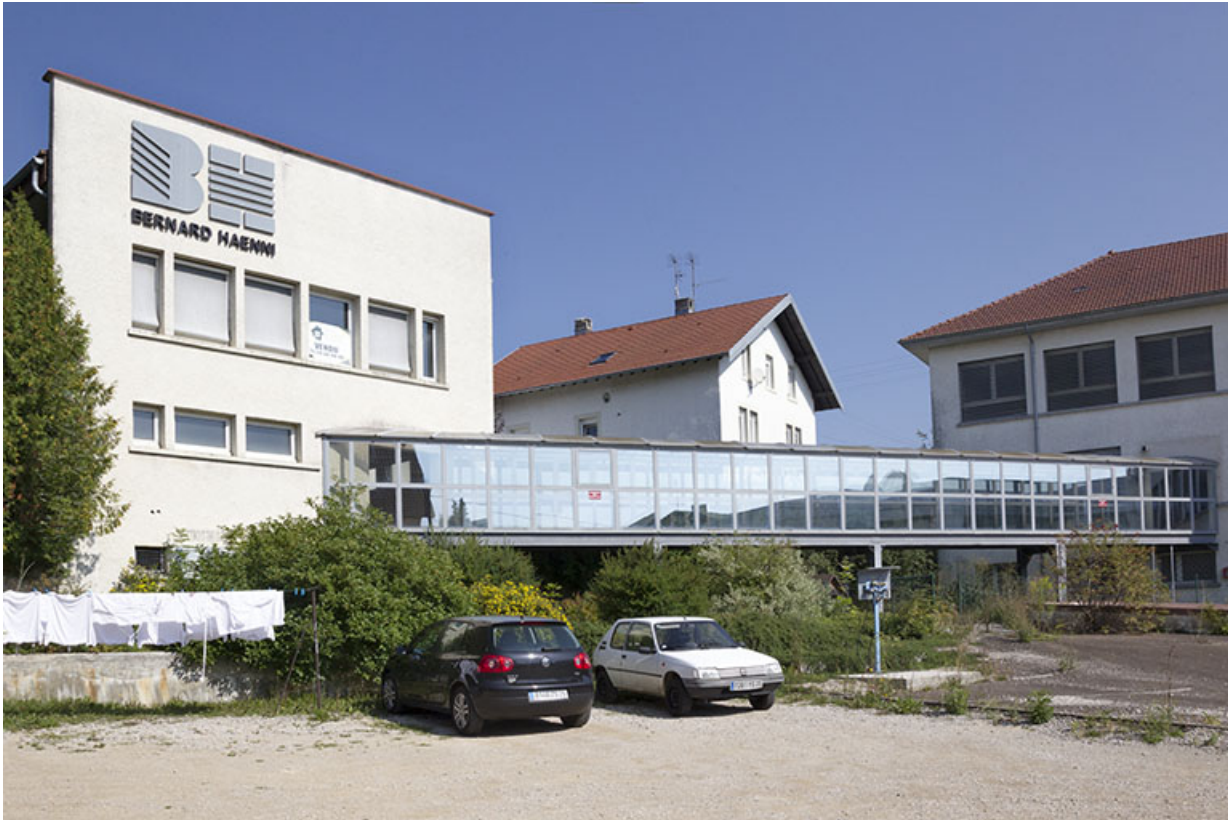
Usine, 2e corps de bâtiment (extrémité de la façade postérieure à droite) et passerelle de liaison avec l'ancien site Léon-Georges Petit.
