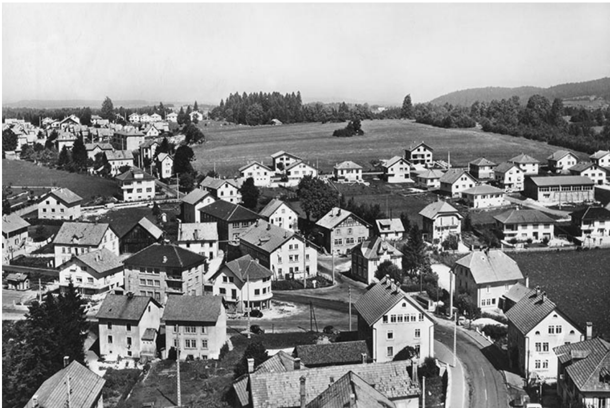
En avion au-dessus de... 7. Charquemont (Doubs) [vue aérienne des rues de la Gare, Victor Hugo et des Villas depuis le sud], entre 1958 et 1967.
