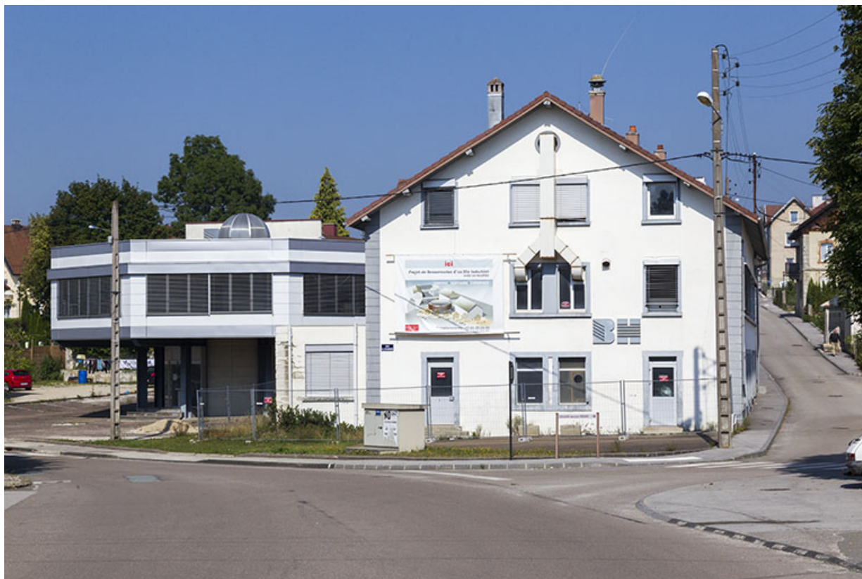
Corps d'entrée et usine, vus de l'est.
