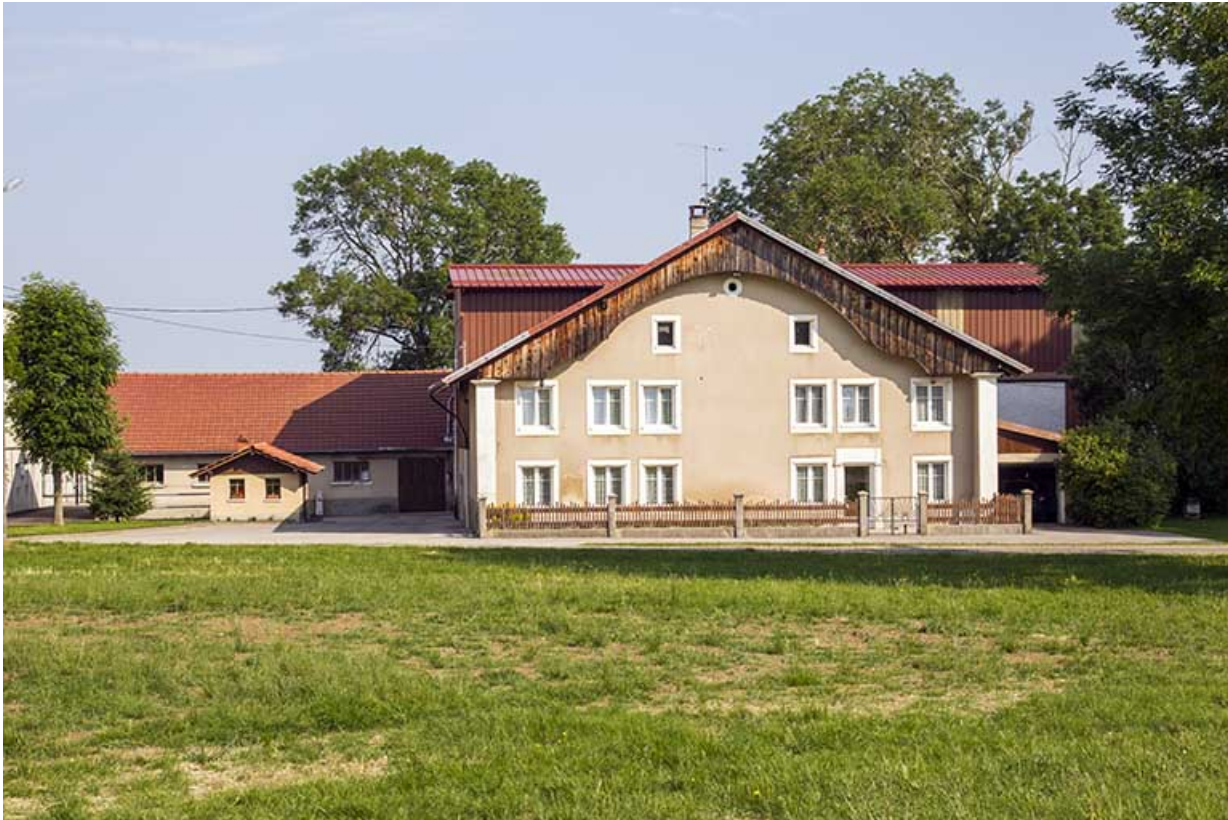
Bâtiment 19e siècle, étable et fenil des années 1960-1970.
