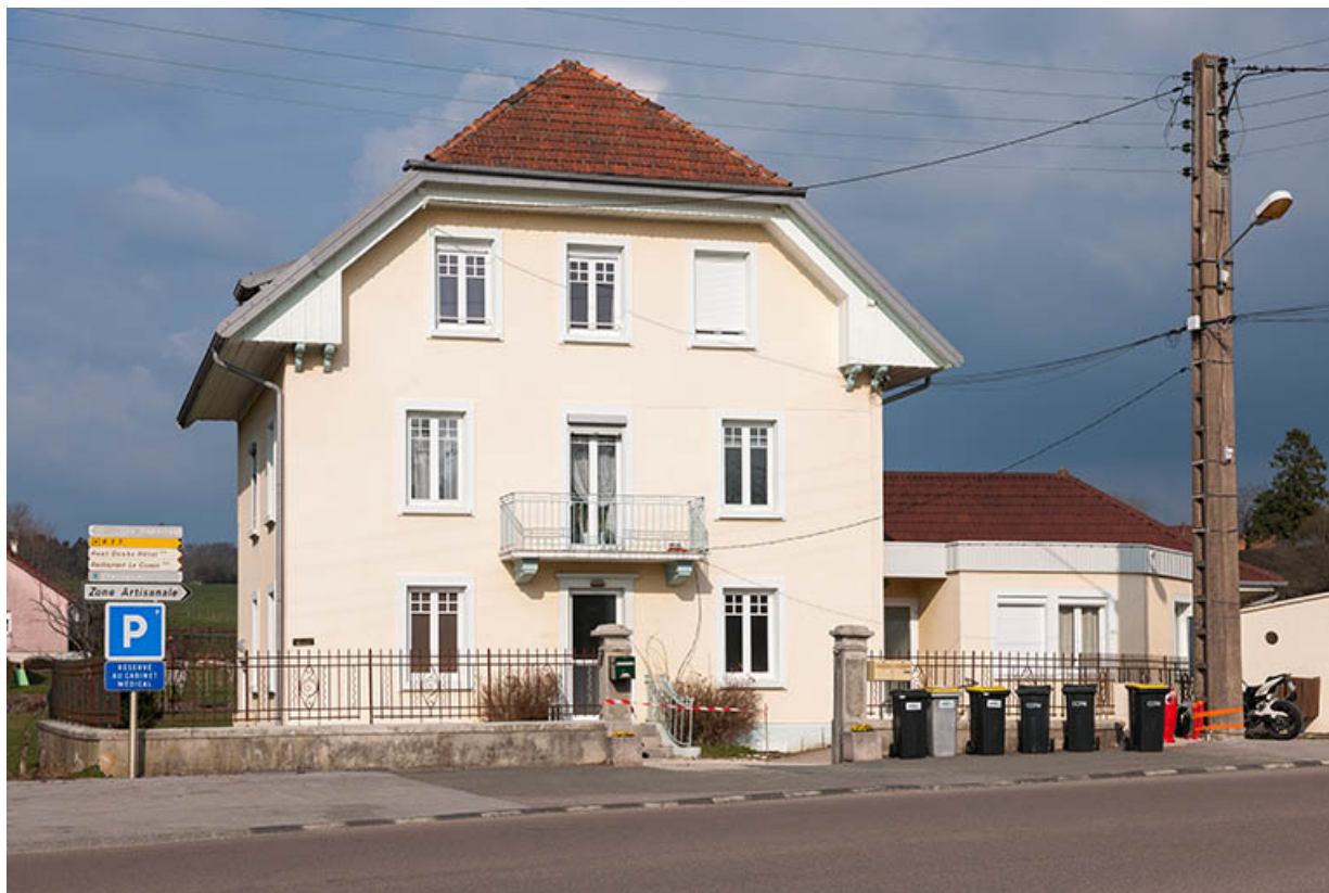
Vue d'ensemble, depuis l'ouest (façade antérieure).
