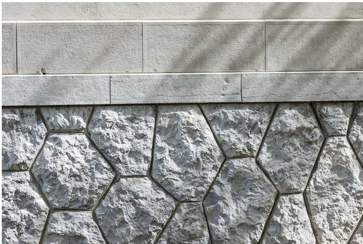
Façade postérieure : détail de l'appareil du soubassement.
