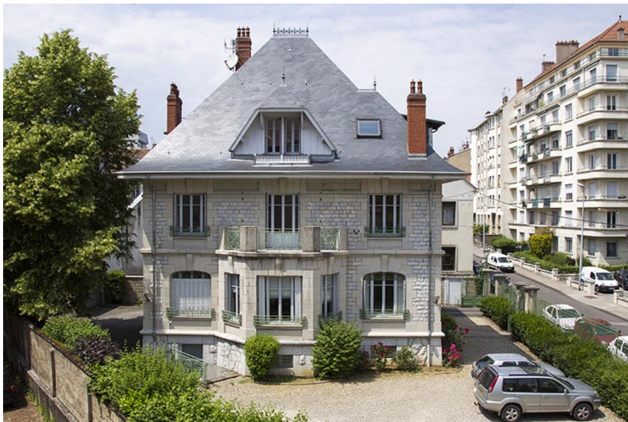
Vue d'ensemble plongeante sur la façade latérale gauche.
