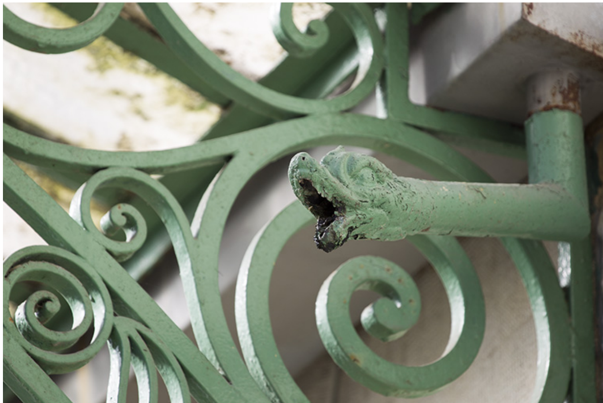
Façade antérieure : gargouille de la marquise (côté droit).
