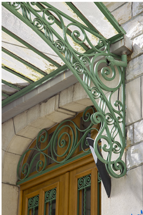
Façade antérieure : ferronnerie de la marquise (côté droit).
