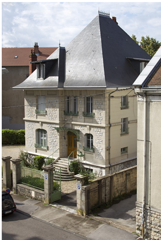
Vue plongeante sur la façade antérieure.
