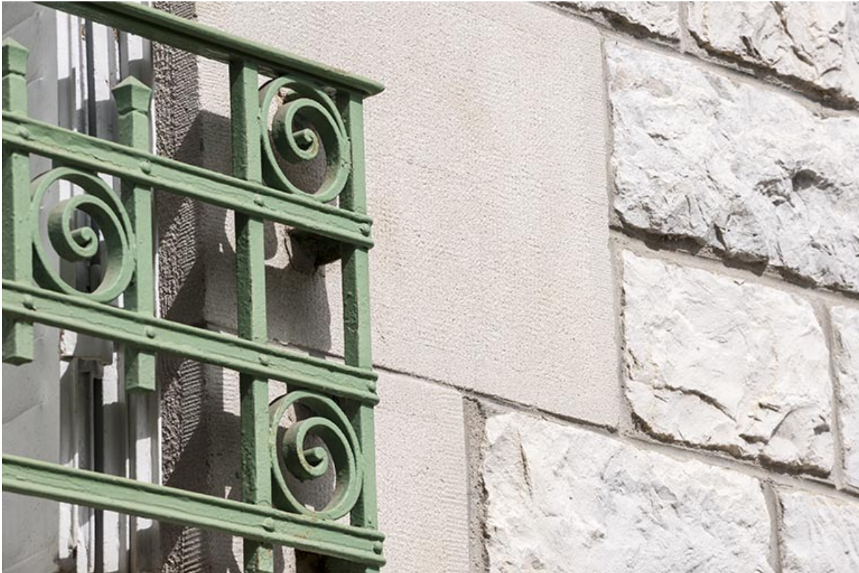
Façade latérale gauche : détail de l'appareillage du mur, de l'encadrement de fenêtre en béton et de la ferronnerie. 25, Besançon, 1 bis rue Victor Delavelle
