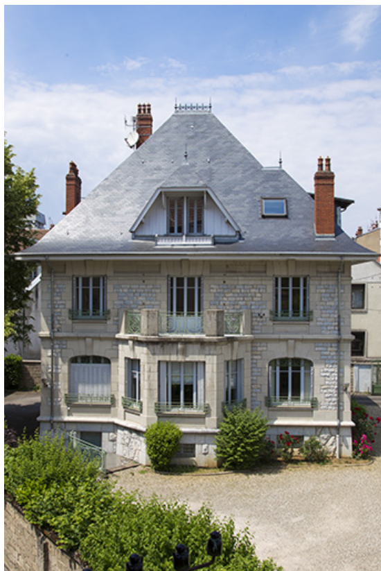
Vue d'ensemble plongeante sur la façade latérale gauche (cadrage vertical). 25, Besançon, 1 bis rue Victor Delavelle
