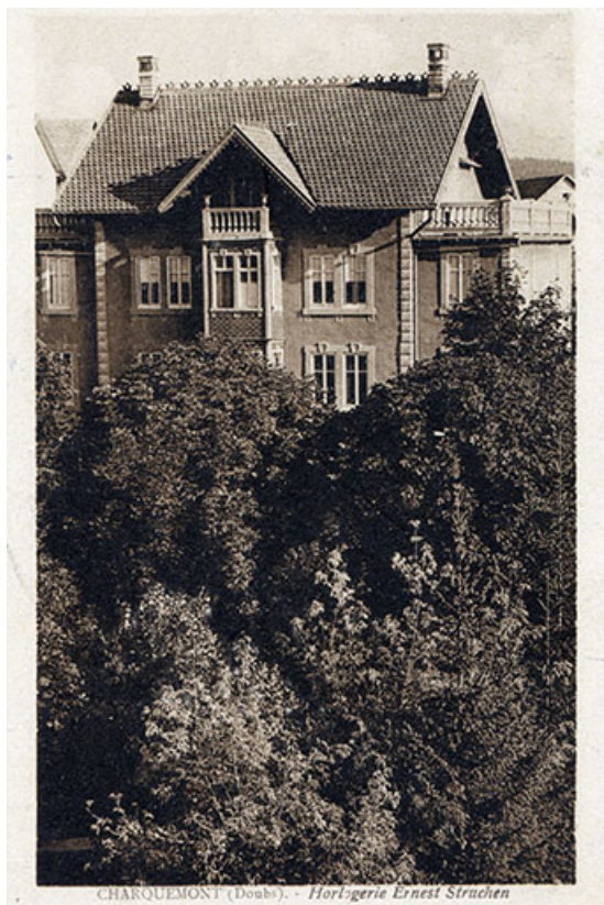
Charquemont (Doubs). - Horlogerie Ernest Struchen [façade postérieure de la maison], 1ère moitié 20e siècle. 25, Charquemont, 4 et 6 Rue Neuve
