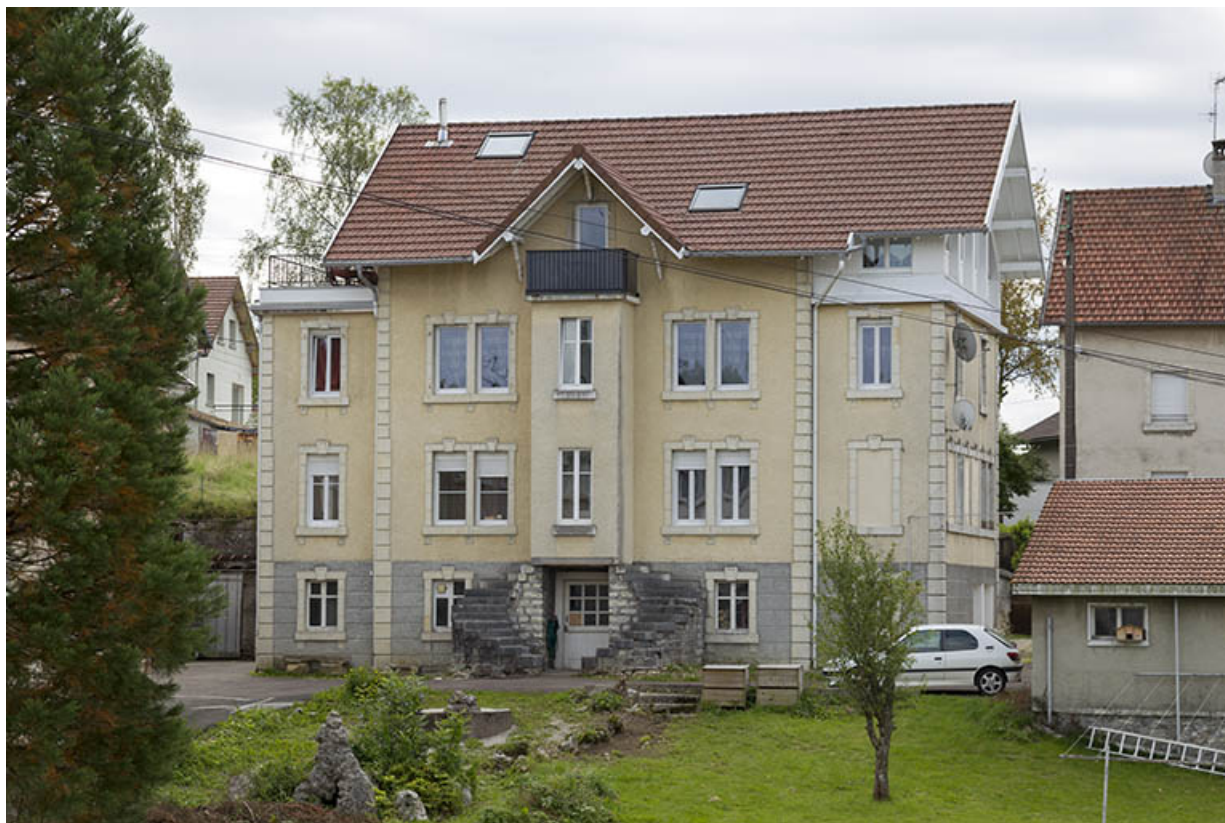
Maison : façade postérieure.
