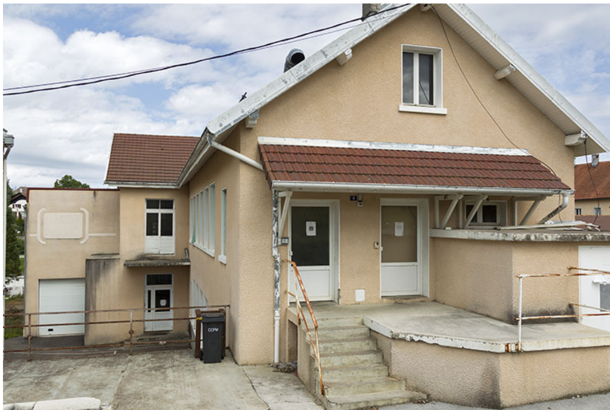
Usine : façade antérieure.
