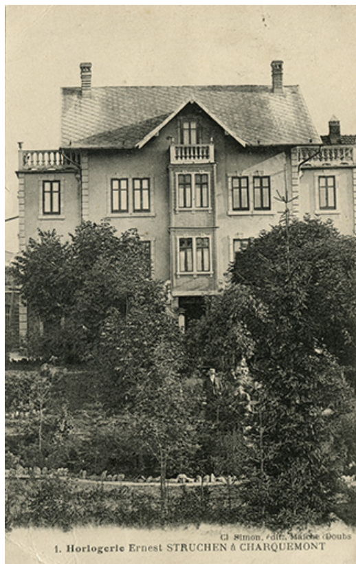
1. Horlogerie Ernest Struchen à Charquemont [façade postérieure de la maison], 1ère moitié 20e siècle. 25, Charquemont, 4 et 6 Rue Neuve
