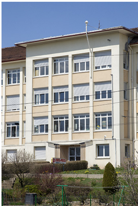
Avant-corps central de la façade antérieure.
