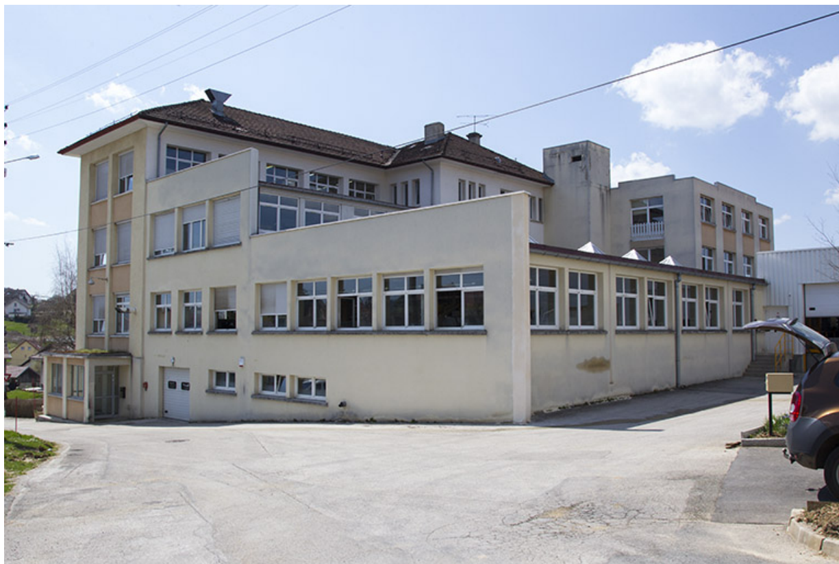
Façades latérale droite et postérieure. L'extension de 1998 se trouve au premier plan. 25, Charquemont, 18 rue de Besançon
