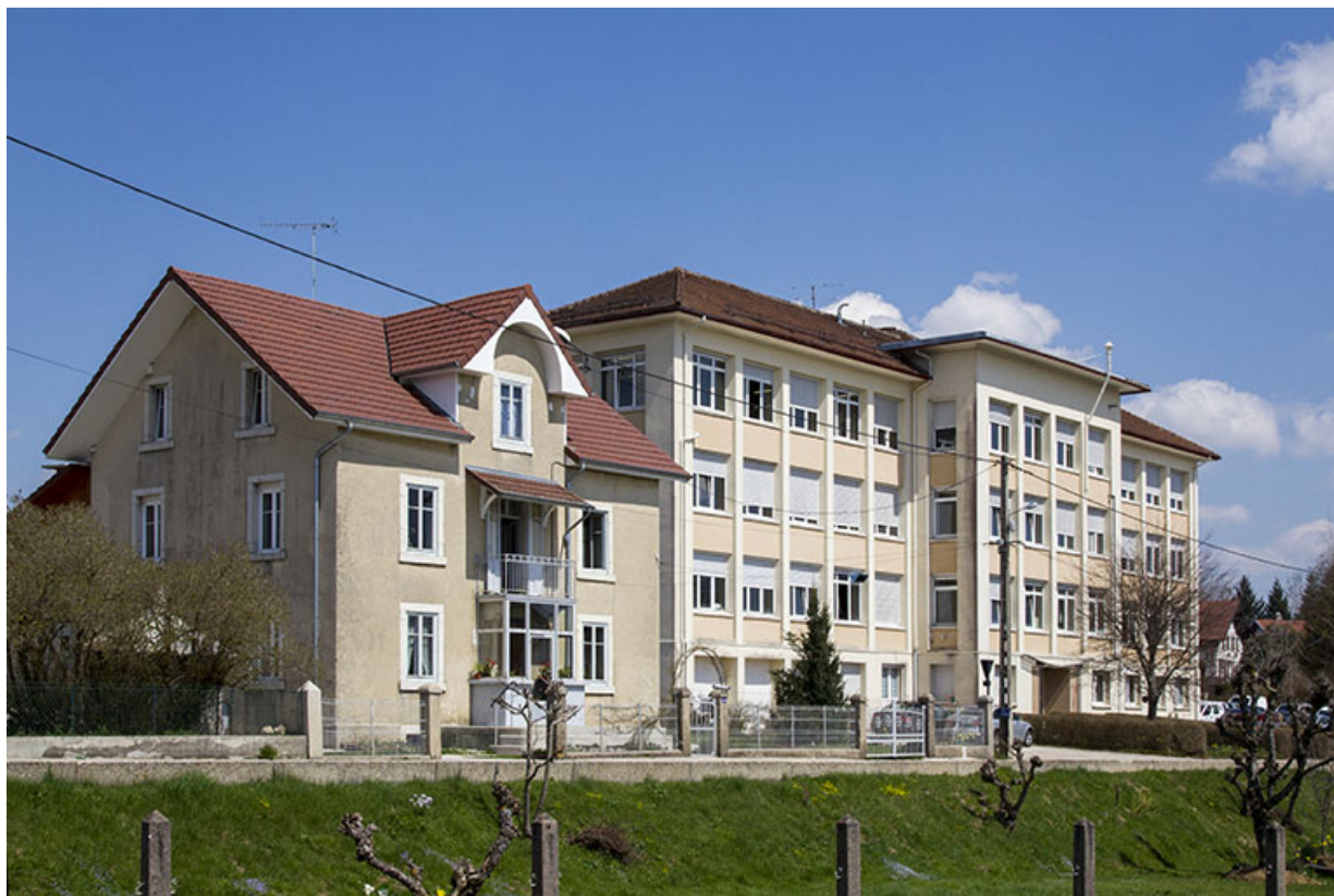
Façade antérieure, vue en enfilade depuis l'ouest.
