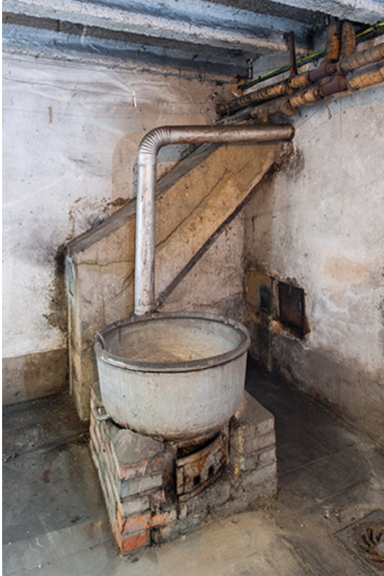
Bâtiment de l'administration, sous-sol : chaudron à lessive.
