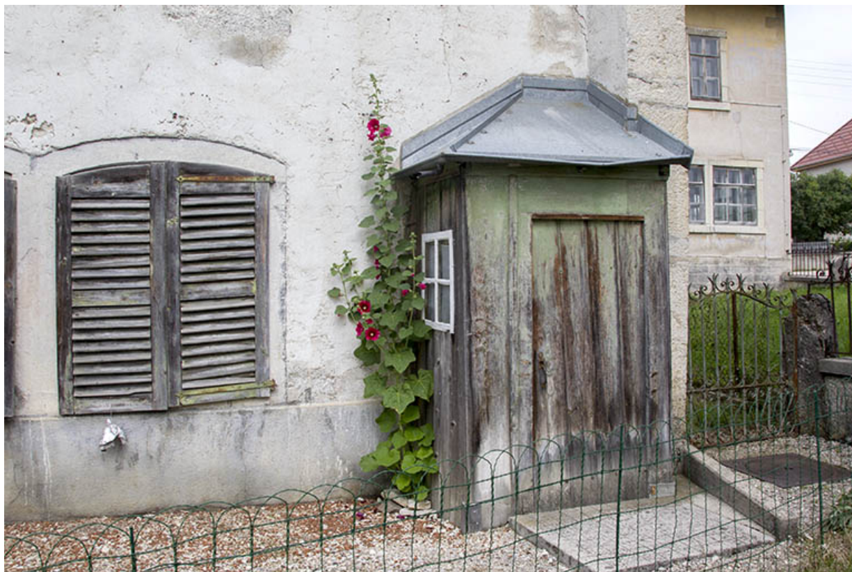
Façade antérieure : fenêtre du rez-de-chaussée et édicule.
