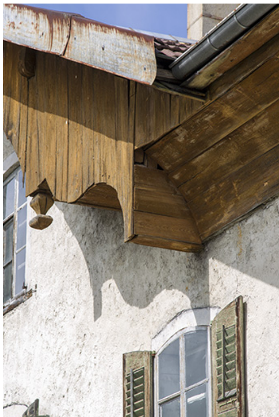
Façade antérieure : extrémité droite de la lambrichure et motif décoratif ornant l'extrémité pendante d'un poteau. 25, Charquemont, 9 Grande Rue
