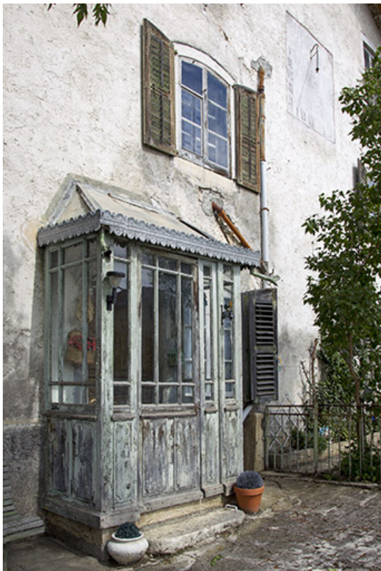
Façade antérieure : véranda, de trois quarts gauche. 25, Charquemont, 9 Grande Rue
