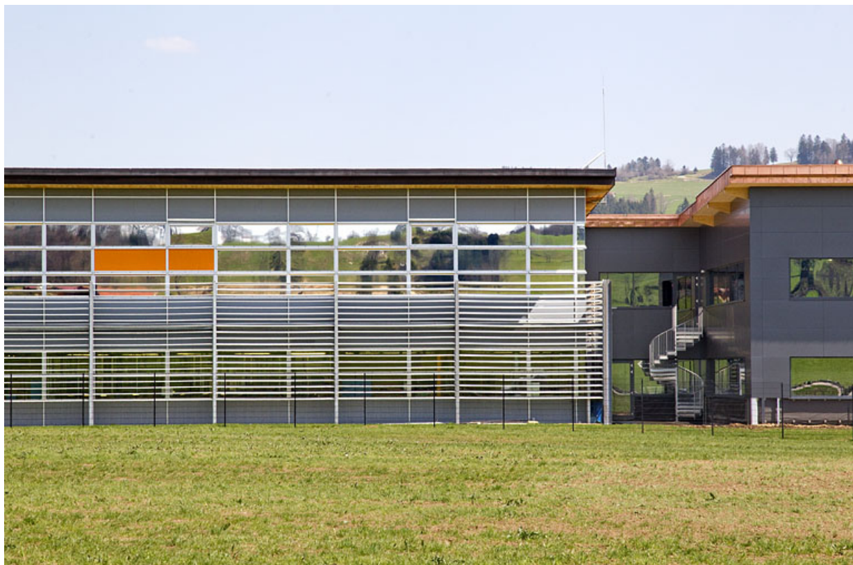
Une usine du 21e siècle (2002, Sexer Loyrette Architecture) : usine de balanciers-spiraux Frésard Composants (4 rue Pierre Frésard).
