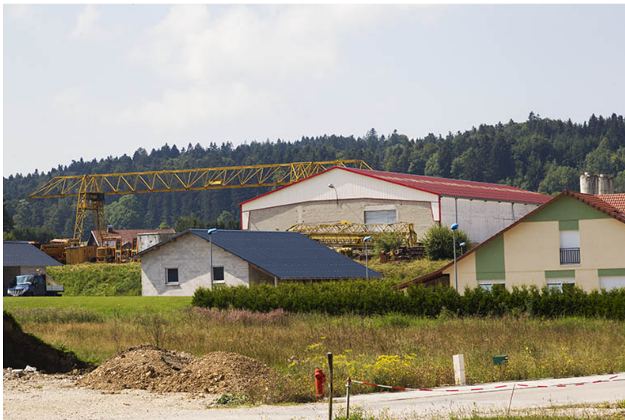
Atelier est (mur pignon) et portique roulant. 25, Frambouhans, 10 Grande Rue
