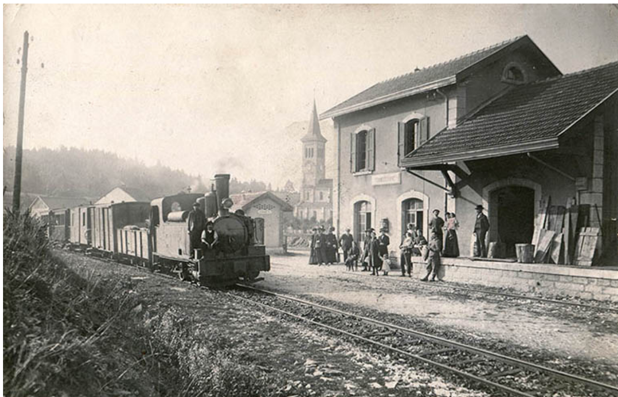
[La gare de Frambouhans, avec train et personnages], entre 1905 et 1913.
