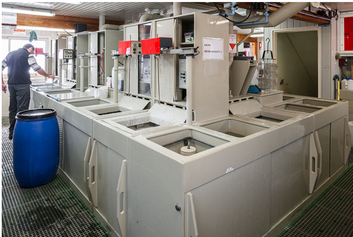
Usine : atelier de galvanoplastie (installations de l'îlot central depuis l'angle nord). 25, Frambouhans, 4 rue de la Velle
