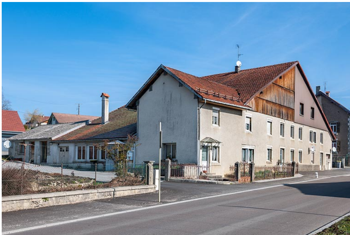
Ferme : vue d'ensemble, depuis le sud. L'atelier de galvanoplastie occupait la partie gauche des bâtiments. 25, Frambouhans, 4 rue de la Velle
