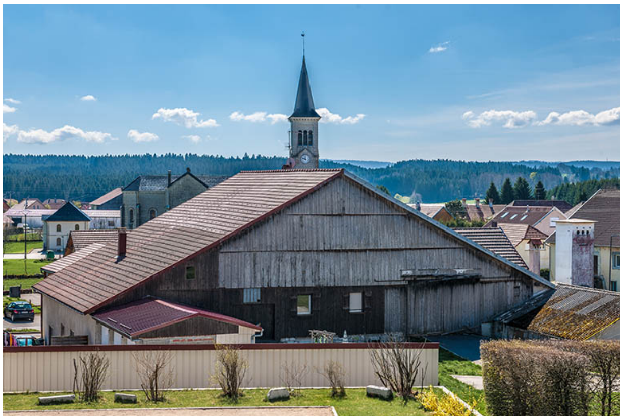
Ferme : façade postérieure.
