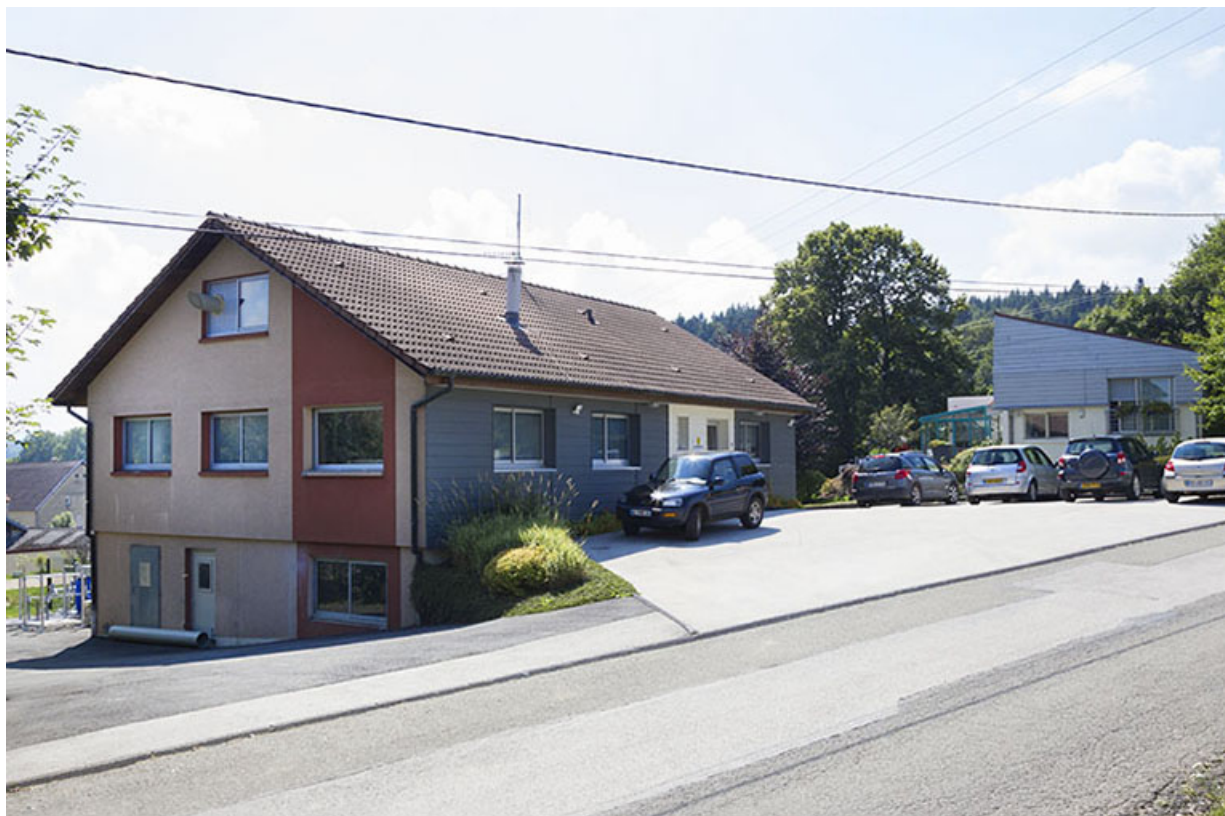
Usine : façade antérieure.
